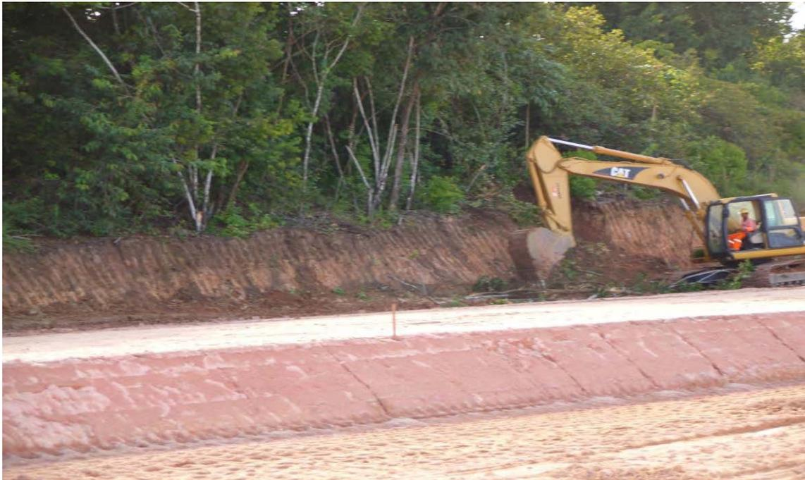
**Figura 15: Retirada da Mata e terraplenagem para expansão do CIPS em sua área central**
