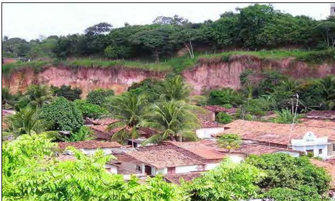
FIGURA 2.6 - Foto da barreira no Timbó: marcas da escavação.
