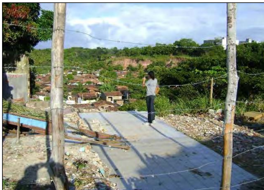
FIGURA 4.7 – Foto de piso de casa demolida sobre a encosta
