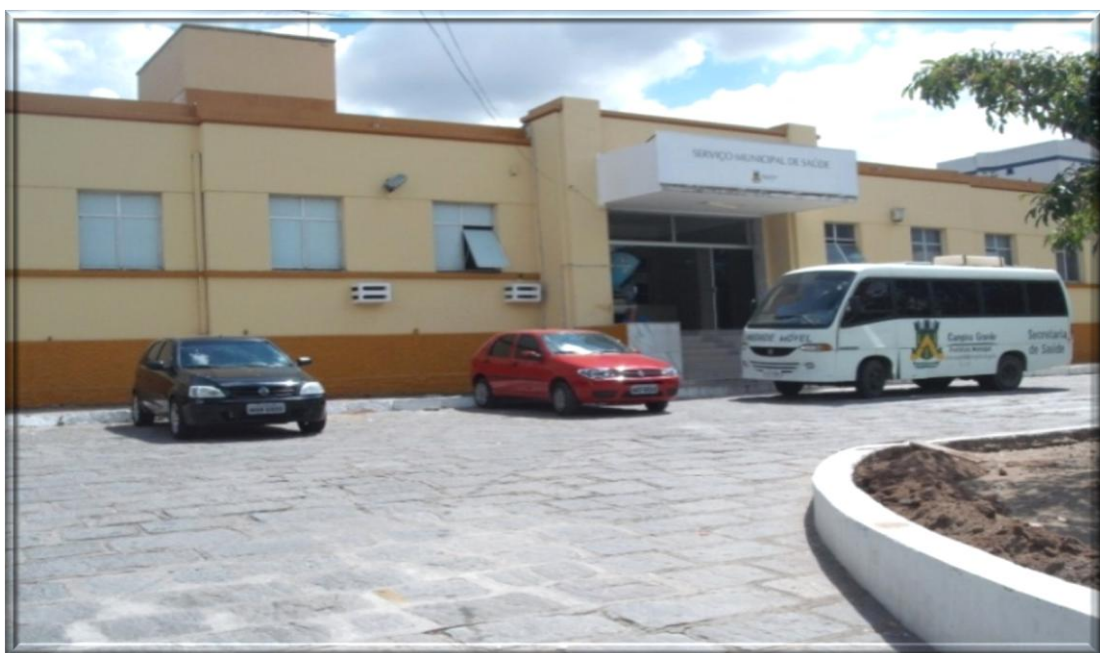
Figura 13: Centro do serviço Municipal de Saúde, Antiga Casa de Saúde, Bairro da Prata, Acervo da Autora, Campina Grande. 2010.
