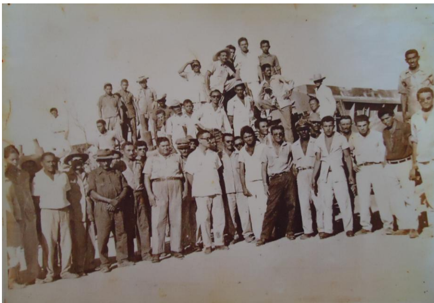
Sr. Guimarães usando chapéu (4º da esquerda para direita) ao lado dos companheiros construtores de Boqueirão. Por trás, um dos caminhões batizado de “track-trucks” (Acervo pessoal do Sr. Guimarães).
