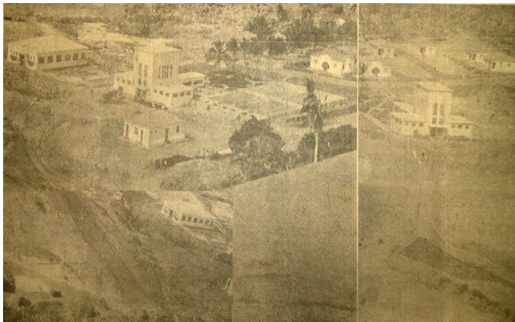
Vista aérea da construção, ainda em andamento, da barragem de Marés (A União, 28/01/1951, p.1).
