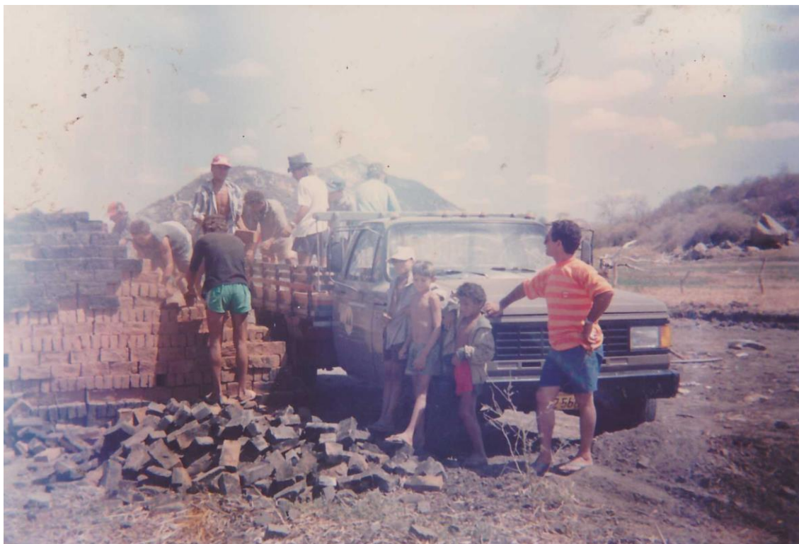
FIGURA 9 - Construção das casas no assentamento Recanto após a conquista da luta – 1993. Fonte: Arquivo fotográfico da CPT-Sertão-PB.
