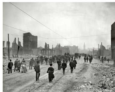
Figura 2: O mesmo local depois do terremoto.
