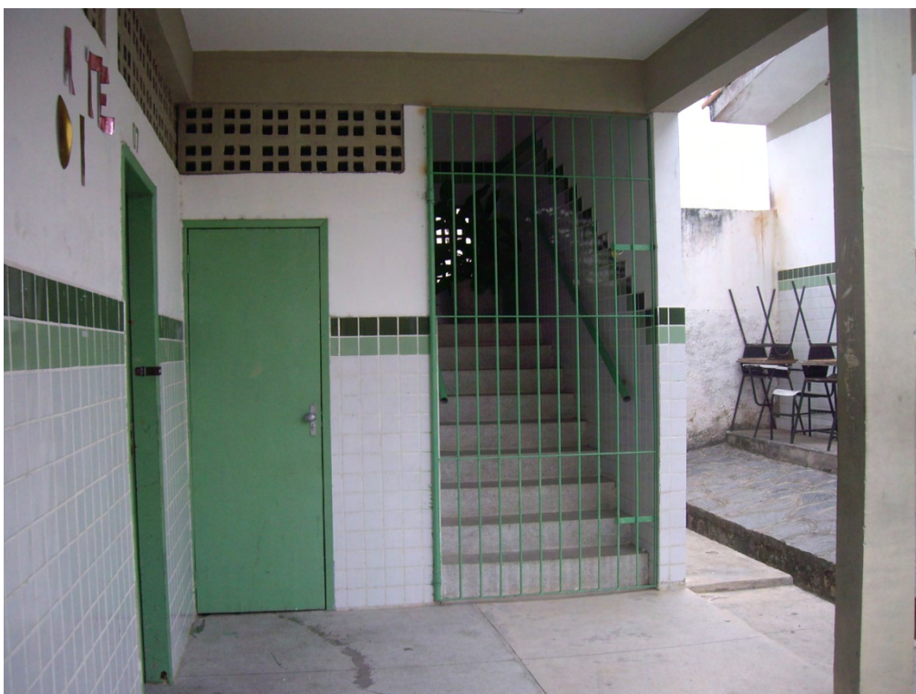
Foto 8: Escada de acesso às salas das turmas do ensino médio.
