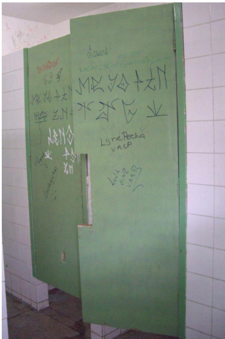
Foto 6: Área interna do banheiro masculino
