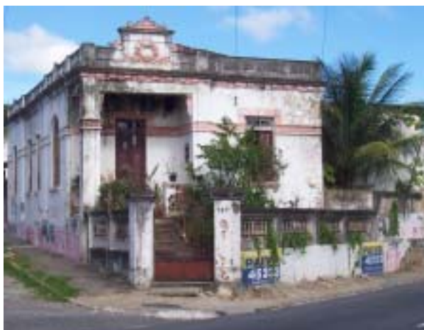
Fotografia 9: Imóvel nº 490 da Rua das Trincheiras, residência do casal Simeão e Eloah Foto: Kehrle, Luis Carlos
