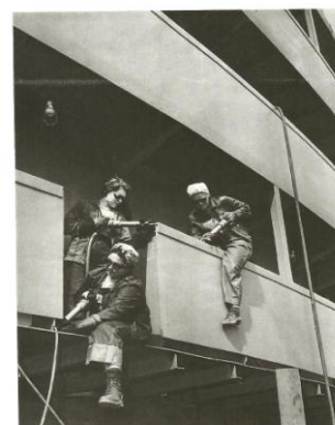
(Fig16:Rosies na construção de um navio - EUA, 1942)
