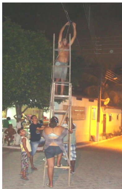
FIGURA 21: Os membros do grupo colocando a lâmpada na rua para o ensaio.
