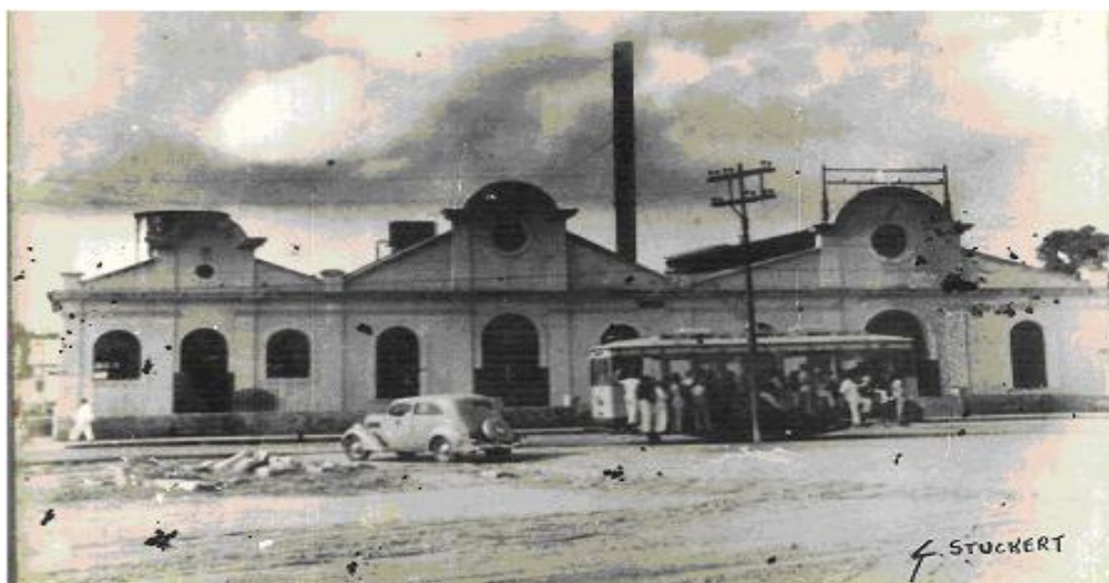
Figura 2: Estação Elétrica da Cruz do Peixe Eptácio Pessoa 1951
