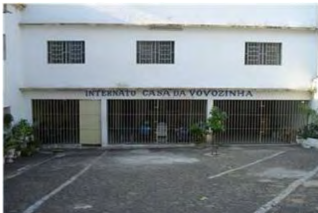
FOTO 03 – Internato Casa da Vovozinha (Data: 18/06/2007)
