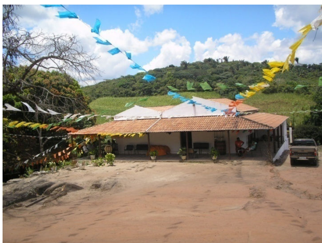
Figura 47 – Vista frontal da Casa Grande.
