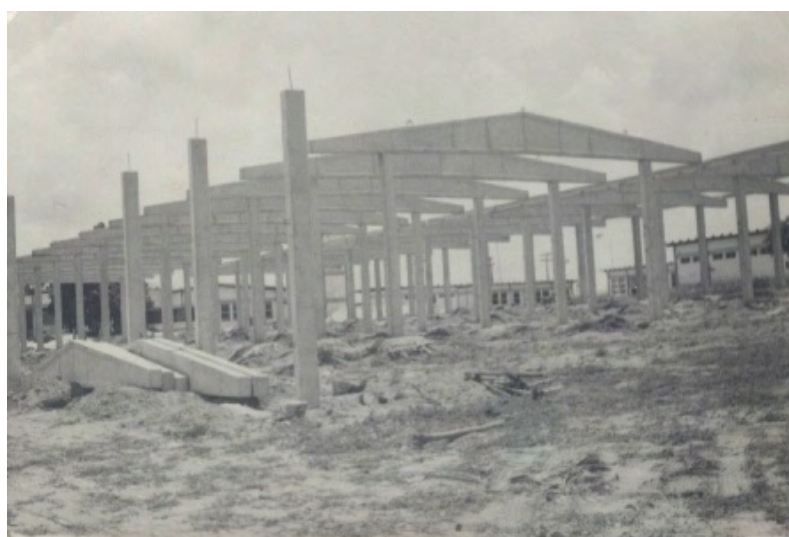
FIGURA 18: Obras em andamento do Centro de Ensino. FONTE: Arquivos do Centro de Ensino (s.d.).
