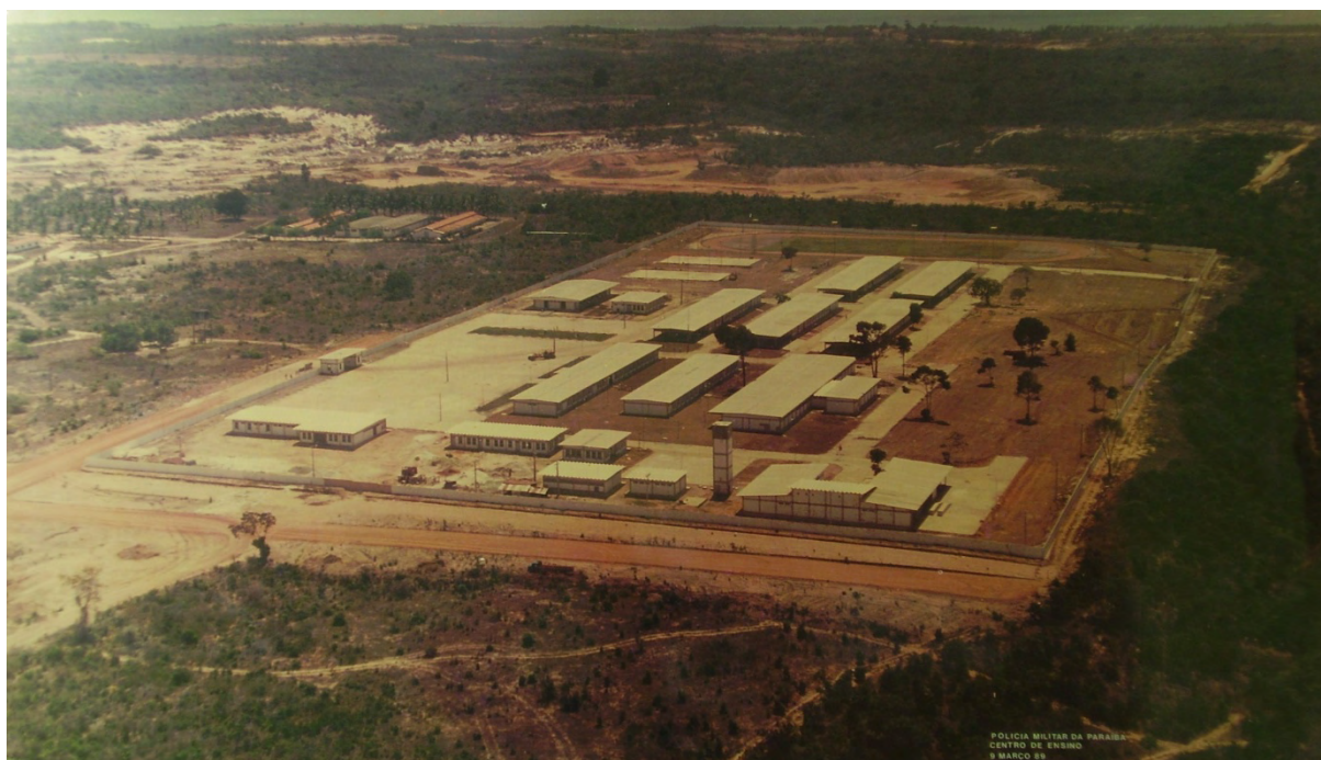
FIGURA 5: Vista aérea do Centro de Ensino após conclusão das obras de construção. FONTE: Arquivos do Centro de Ensino (1989).
