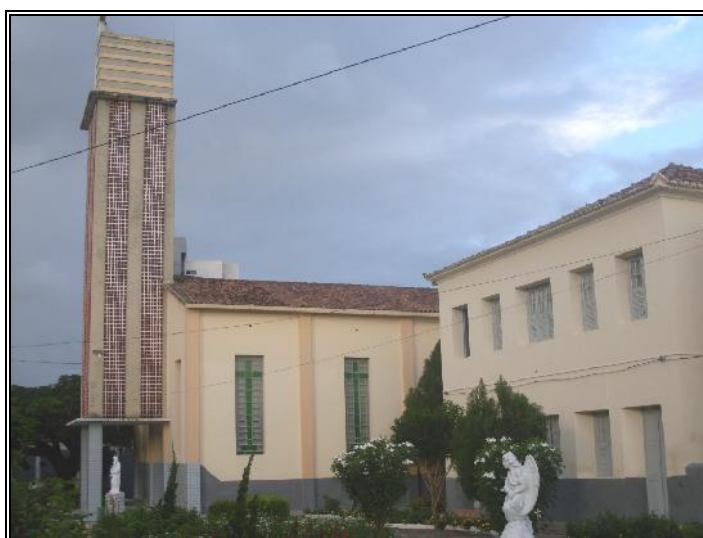
Capela e Prédio principal do Instituto (Foto1 – Acervo Pessoal de Pesquisa)
