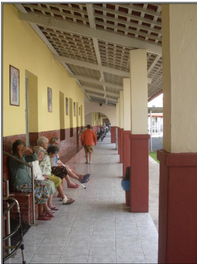
Corredor do prédio do asilo que dá acesso às alas masculinas e femininas e ao salão principal (Acervo Pessoal de Pesquisa)
