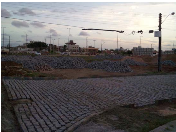
FOTO 38 – Após vários protestos e ações coletivas as ruas do bairro e da praça começam a ser calçadas e asfaltadas. Janeiro de 2010. Créditos: Ricardo Campos
