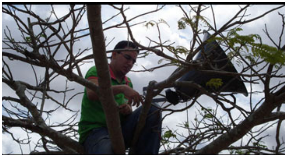
Ilustração IX- Instalação de alto-falante
