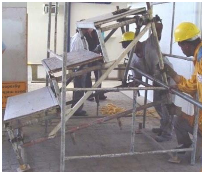
Figura 3.10 – Pequeno protótipo de arquibancada Adaptado de Brito (2005)
