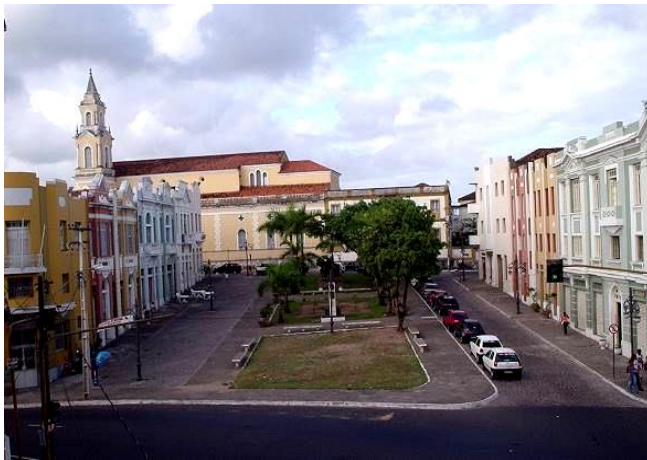
Figura 80: Praça Anthenor Navarro com três canteiros e um calçadão em substituição à rua que define a lateral oeste da mesma, 2005. Fonte: Camila Cesar.
