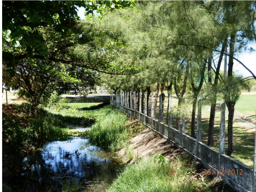
Figura 31- Canal com interferência antrópica: Mureta e plantação de árvores nas bordas do canal
