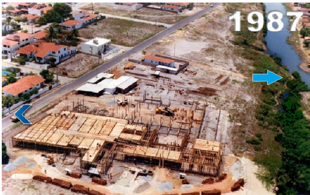
Figura 6 - Construção do Shopping Manaíra e indicação do ponto de desvio do rio Jaguaribe. Fonte: Google
