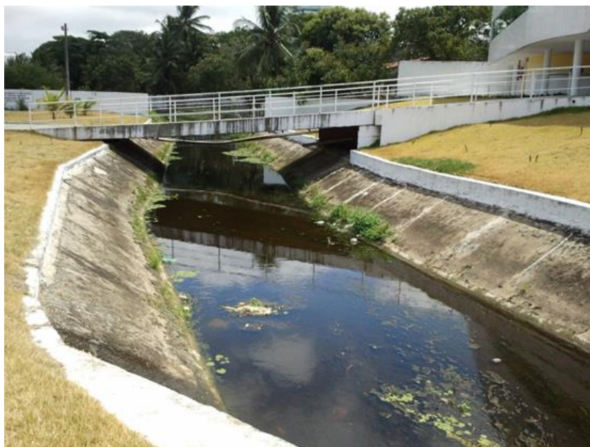
Figura 28 - Trecho do canal atravessando propriedade particular
