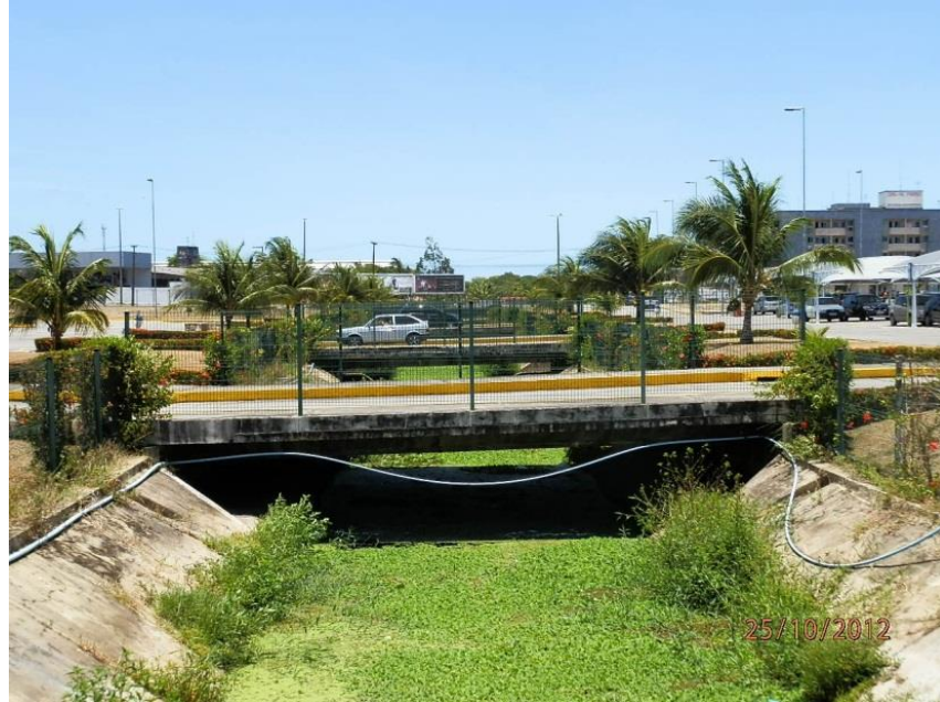
Figura 33 - Canal em frente ao supermercado Carrefour
