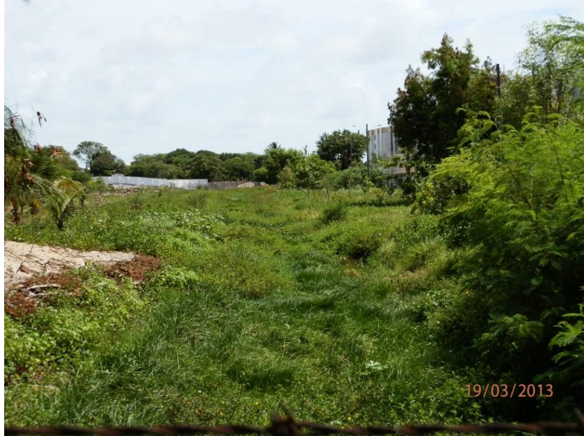
Figura 37 - Final do canal concretado. Aterro indevido às margens do rio
