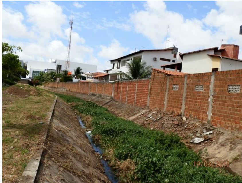
Figura 27 - Trecho do canal com margem direita ocupada com residências e muro faz limite com calha do canal. Situação análoga a todo canal com presença de vegetação aquática e águas sujas. Retificado e canalizado.
