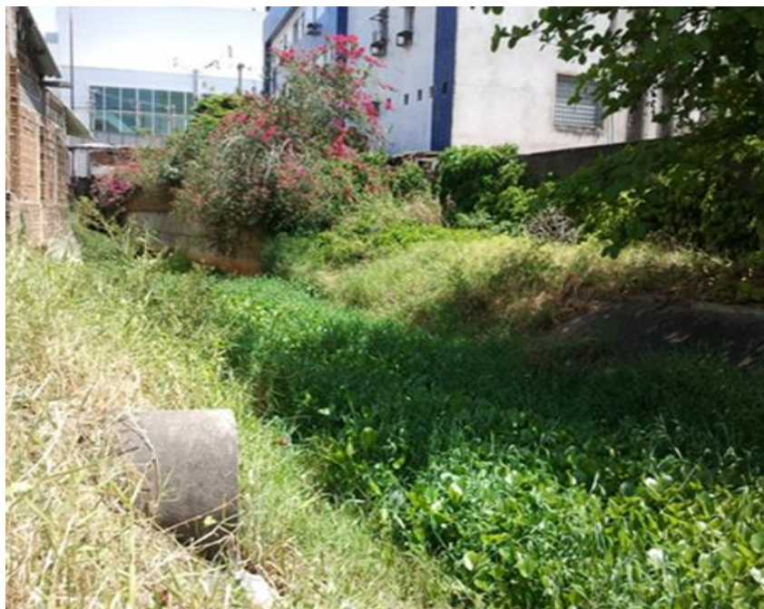
Figura 26 - Presença da rede de águas pluviais dentro do canal do Rio Jaguaribe. E vegetação aquática. Aguapé.
