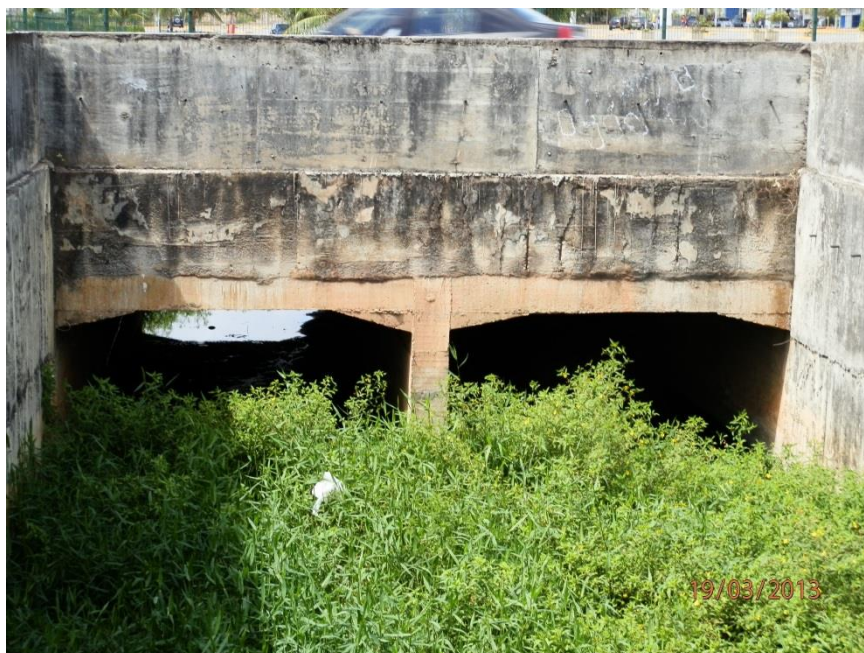
Figura 36 - Passagem sob a avenida
