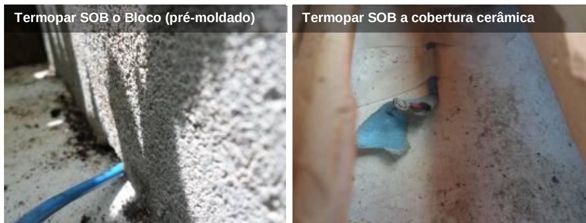
Figura 67: Posição dos termopares na cobertura. Fonte: Acervo Próprio.
