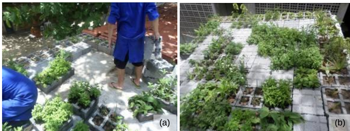
Figura 47: (a) Instalando o Telhado verde do LABEME; (b) Telhado verde no LABEME instalado com blocos TEVA vegetados e blocos TEVA como piso (posição invertida). Fonte: Acervo Próprio.
