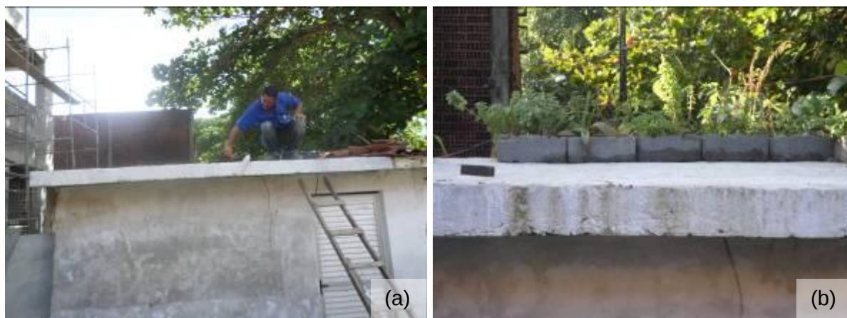
Figura 46: (a) execução da impermeabilização da laje; (b) instalação dos primeiros blocos TEVA vegetados dispostos na laje.
