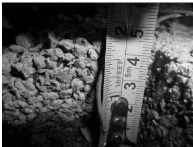
Figura 97: Rebaixamento do nível do substrato no bloco TEVA vegetado, após quatro (4) meses. Fonte: Acervo Próprio.
