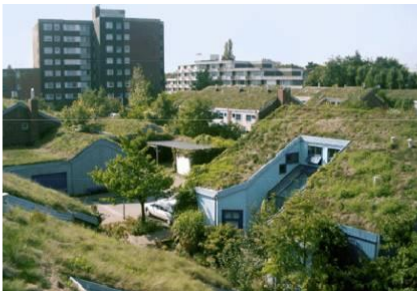
Figura 05: Telhados verdes extensivos em casas na Austrália. Fonte: Wilson (2007 apud Rosseti, 2009).
