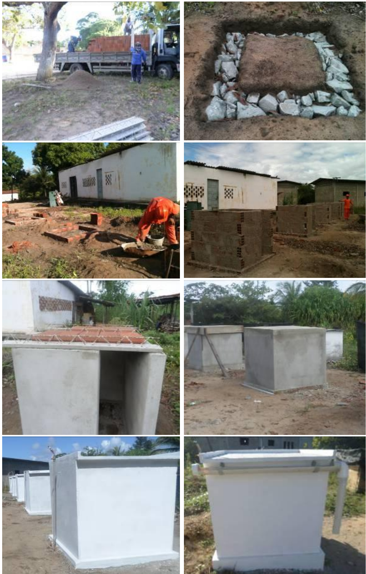
Figura 52: Memorial fotográfico da execução dos protótipos. Fonte: Acervo Próprio.
