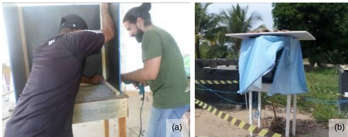
Figura 64: (a) Construção da casa de madeira (abrigo); (b) casa de madeira instalada junto ao protótipo.
