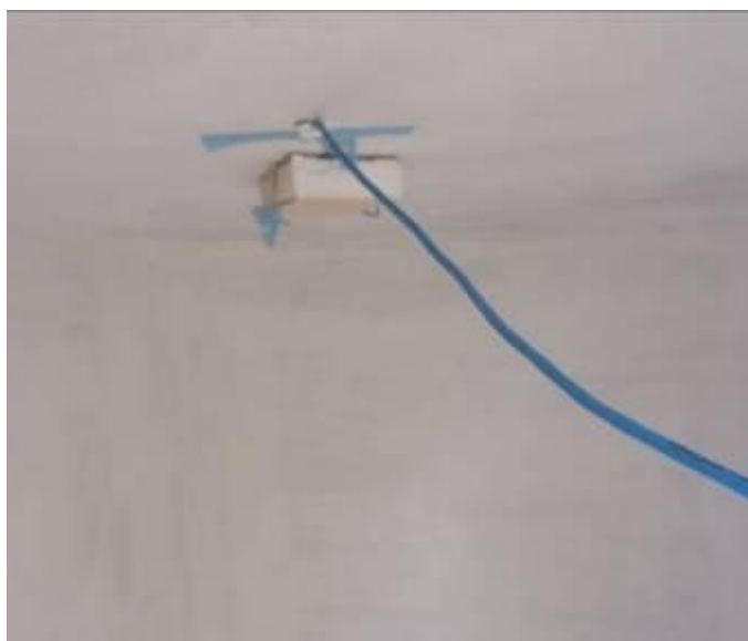
Figura 69: Termopar na face interna do teto da laje. Fonte: Acervo Próprio.
