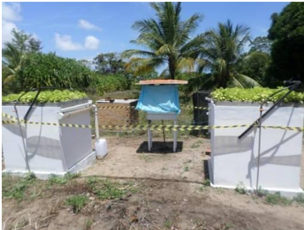
Figura 99: Telhados verdes com blocos TEVA e de concreto, instalados em protótipos no NUPPA. Fonte: Acervo Próprio.
