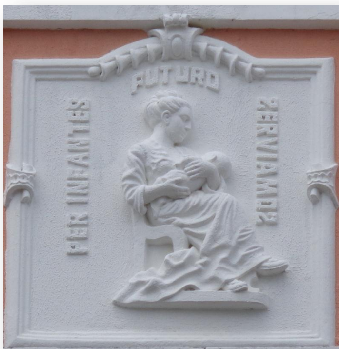
Figura 21 – Parte superior da fachada do Instituto de Proteção e Assistência à Infância do Estado da Parahyba, em João Pessoa-PB
