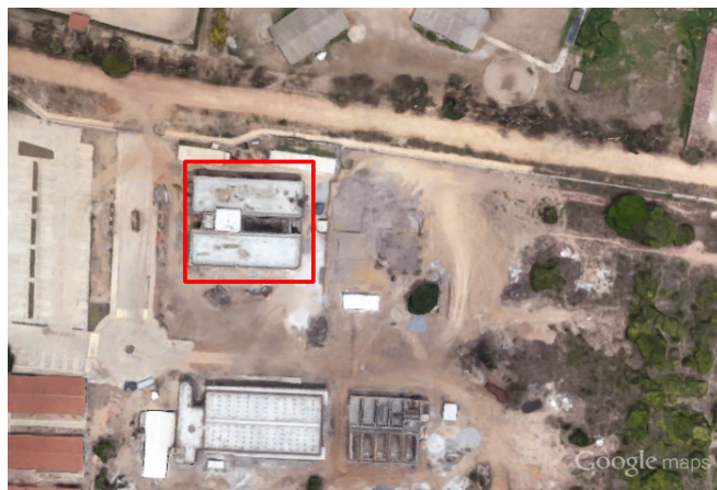
Figura 3.2: Prédio do Centro de Informática da UFPB.
