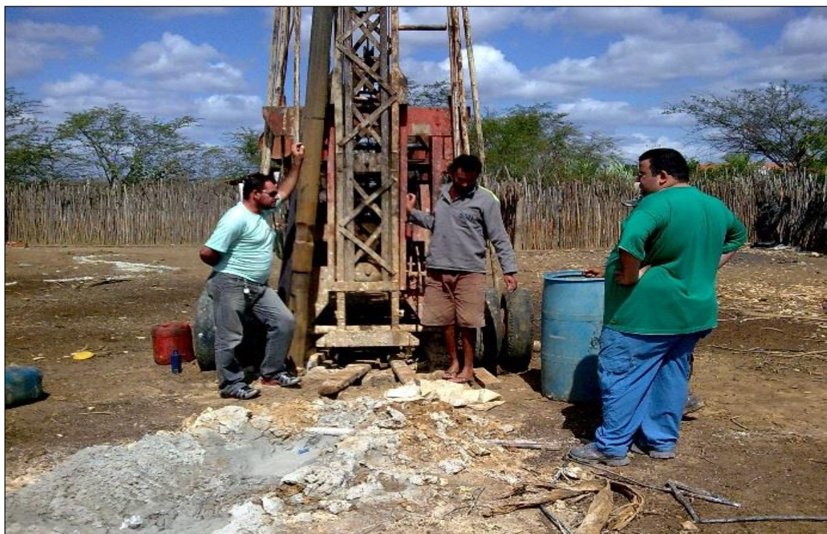
Figura 05 – PA Diamantina – Perfuração de poço profundo para abastecimento humano em 2009. Foto: Rafran Guimarães Pinto, Trabalho de campo da ATES, 2009.
