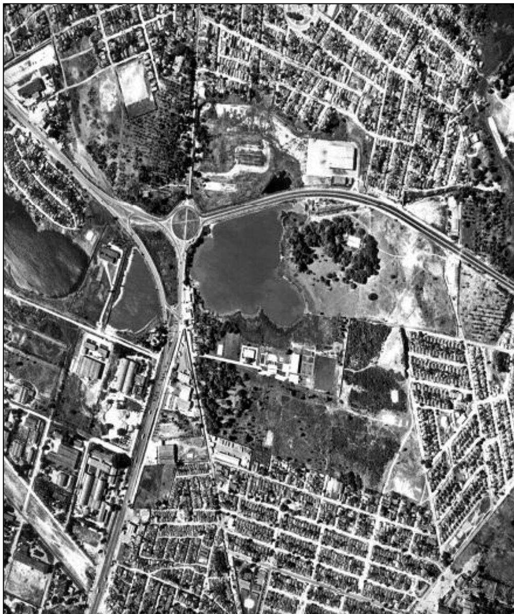
Figura 7 – Degradação da nascente do rio Jaguaribe decorrente de obras de engenharia para melhoramento do sistema viário e construção do Conjunto Residencial Esplanada
