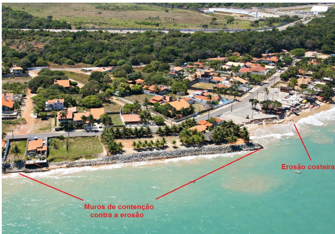
Figura 20 - Elementos urbanos erodidos na praia do Seixas e muro de contenção para evitar a erosão. Fonte: SPU (2013).
