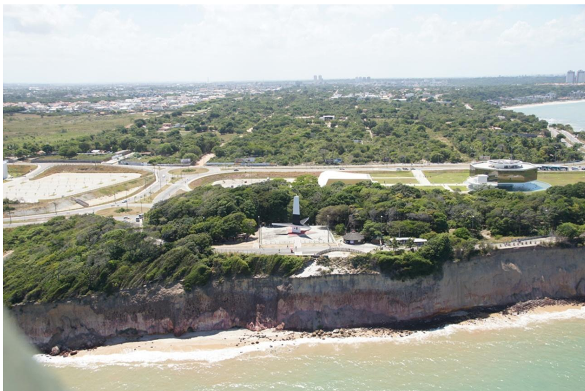
Figura 19 - Elementos urbanos construídos sobre a falésia de Cabo Branco. Fonte: SPU (2013).
