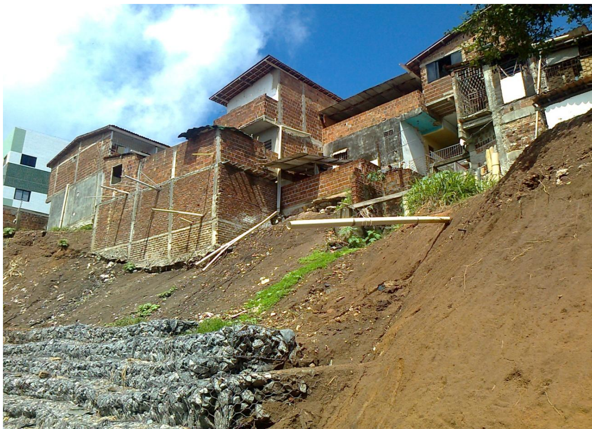
Figura 30 - Moradias construídas no topo de vertentes lançando águas servidas sobre o talude na Comunidade Santa Clara, bairro do Castelo Branco.
