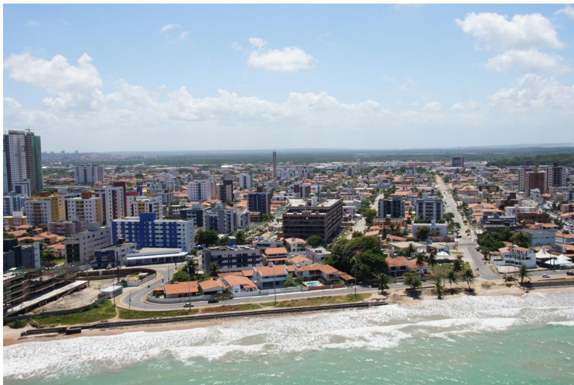
Figura 22 - Avanço da urbanização à linha de costa e ondas avançando até o muro de contenção na praia do Bessa. Fonte: SPU (2013).
