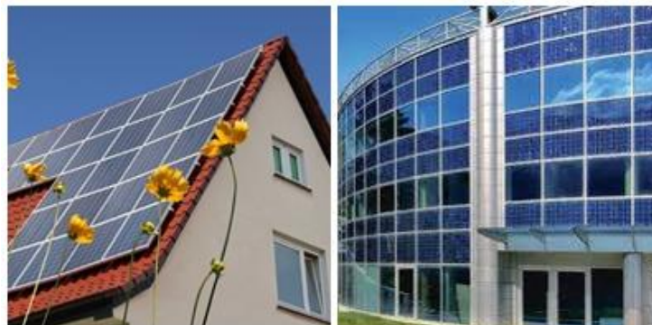
Figura 19 - Instalação em Telhado e Fachada
