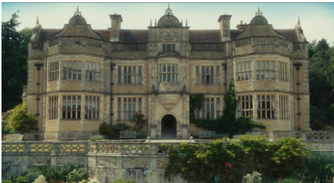
Figura 02 – Imagem da fachada da casa
