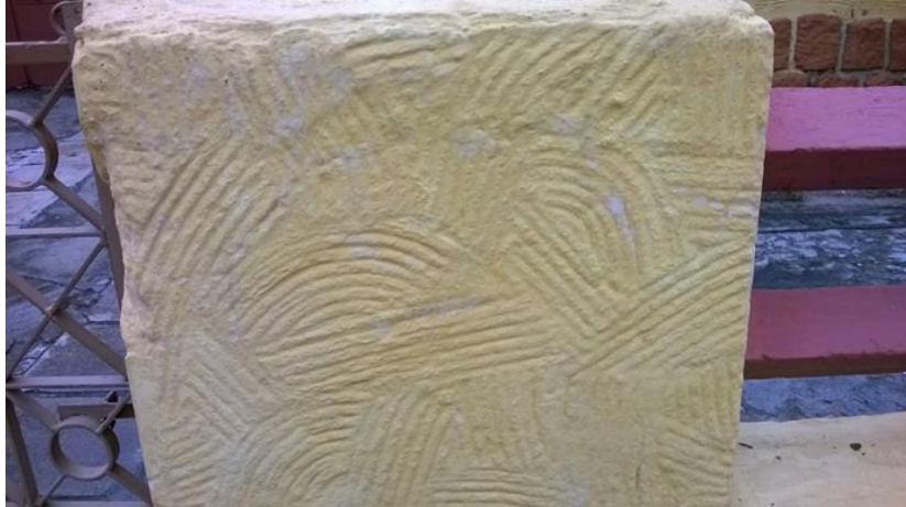
Foto 12 - Detalhe do acabamento da pintura externa do muro da casa de Fortaleza
