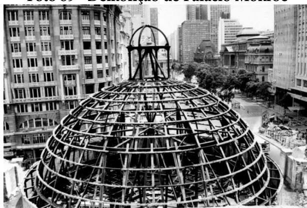
Foto 89 - Demolição de Palácio Monroe
