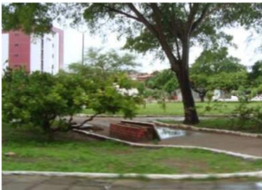
Figura 69 - Bancos quebrados na praça Chateaubriand Arnaud
