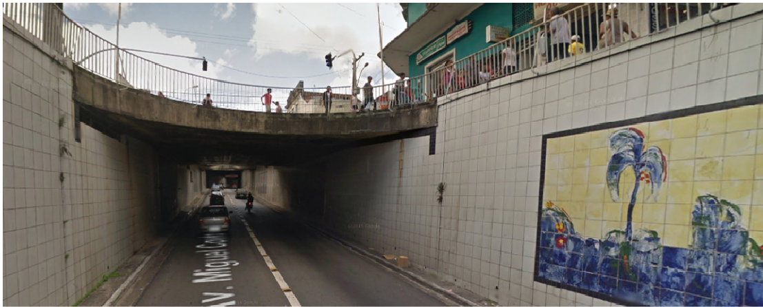
Figura 15 – Perspectiva do viaduto da Av. Miguel Couto. Percurso 03. Fonte: Google Street View, 2014.
