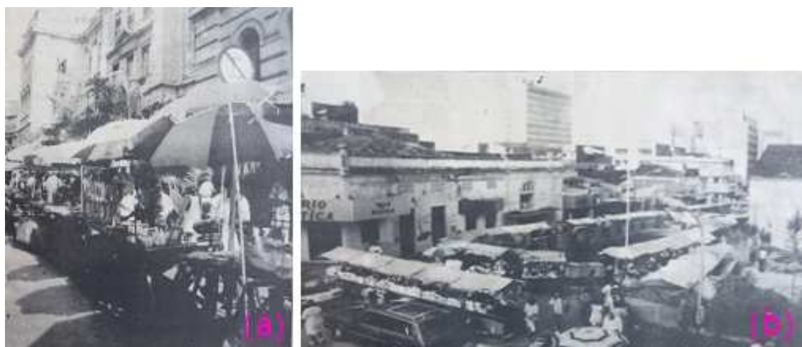
Figura 01 e 02 – (a) Rua Miguel Couto, barracas na calçada em frente à atual Prefeitura Municipal de João Pessoa. Legenda da fotografia no jornal: “As barracas armadas na calçada dificultam a passagem de pedestre”. (b) Calçada da Av. Duque de Caxias. Legenda da fotografia no jornal: “As barracas instaladas pelos camelôs tomam conta das ruas e fazem concorrência com os estabelecimentos comerciais de maior porte”. Fonte: Jornal A União, 1997.
