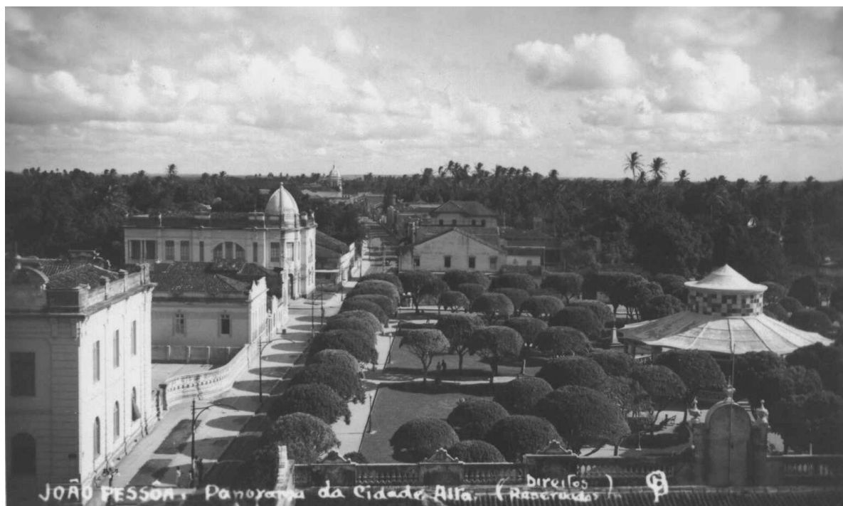
Figura 13: Vista da Praça Venancio Neiva, podendo-se observar a lateral do edifício da Escola Normal (ainda sem o acréscimo, e com área descoberta para recreio). Fonte: Arquivo do IHGP.
