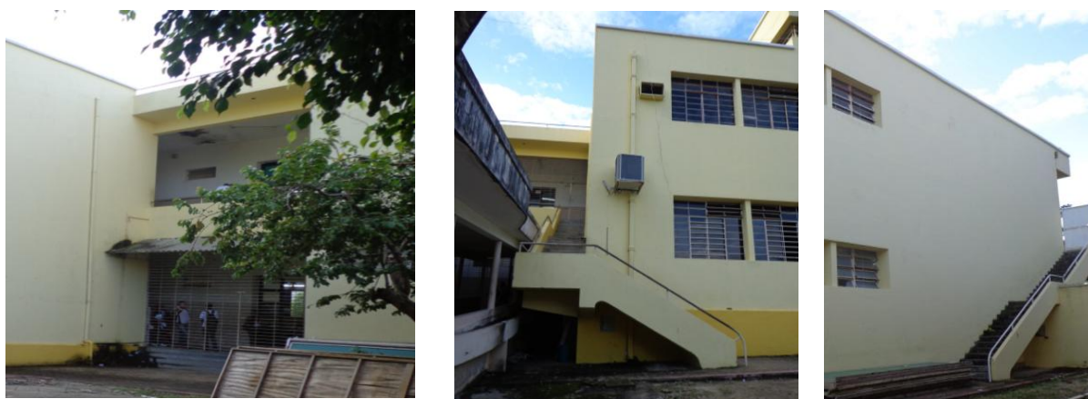
Figura 87: Acessos localizados na parte posterior do Edifício Central: escadaria que leva à ala direita do primeiro pavimento (acesso 3), escadaria que leva à ala direita do segundo pavimento (acesso 7) e escadaria que leva ao setor administrativo do segundo pavimento (acesso 6). Fonte: Acervo da autora, 2013.
