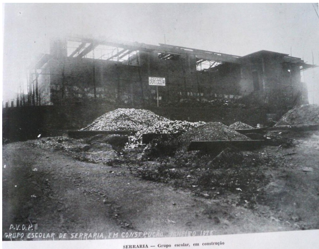
Figura 65: Grupo escolar de Serraria (4 salas de aula), ainda construção em 1938. Fonte: REALIZAÇÕES DO GOVERNO..., 1938.
