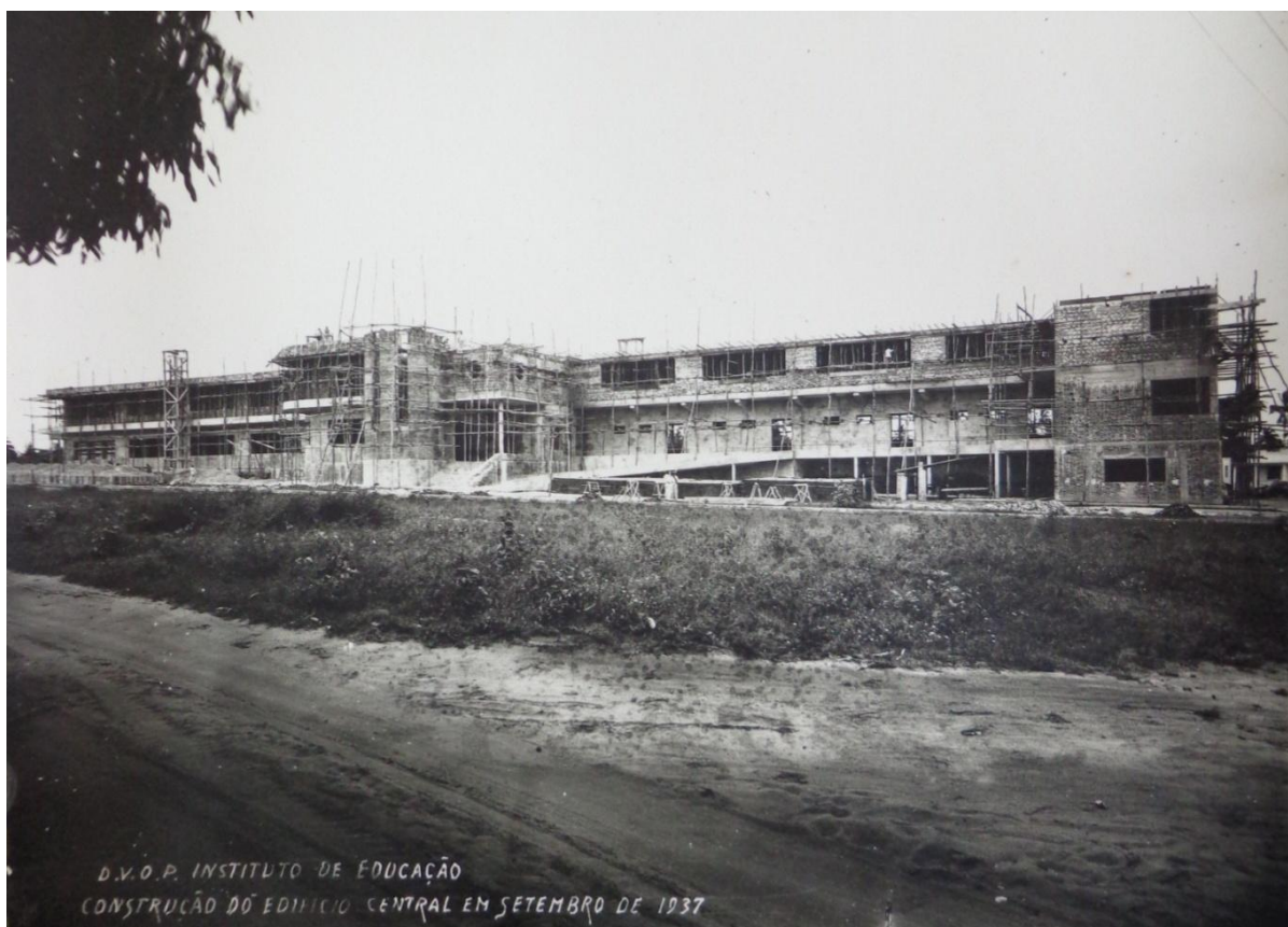
Figura 104: Construção do Edifício Central do Instituto de Educação, em setembro de 1937. A foto mostra a estrutura de concreto armado das lajes entre os pavimentos e da rampa. Fonte: Arquivo do IHGP.
