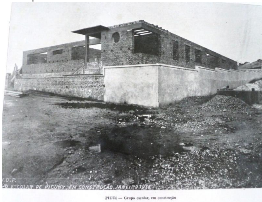
Figura 64: Grupo escolar de Picuí (4 salas de aula), seguindo o novo modelo, ainda construção em 1938. Fonte: REALIZAÇÕES DO GOVERNO...,1938.
