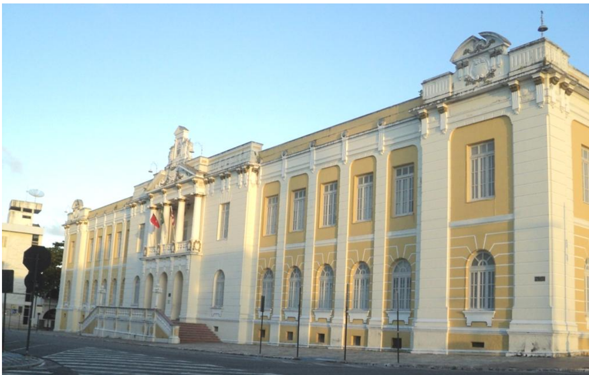
Figura 14: Antigo edifício da Escola Normal, cuja construção iniciou-se em 1917, hoje Tribunal de justiça. Fonte: Acervo pessoal, 2012.
