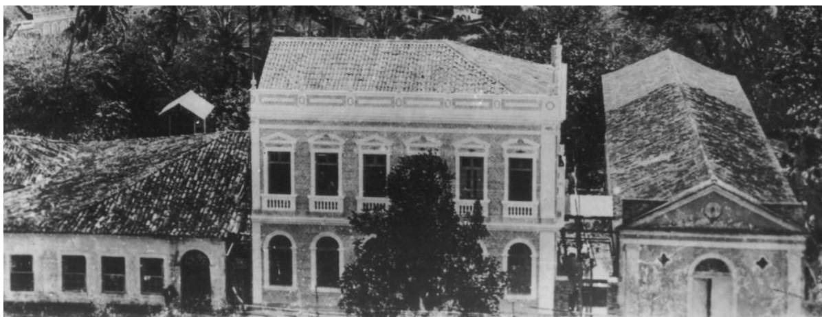
Figura 05: Colégio de N. S a . das Neves, ao centro, em 1906. Fonte: Stuckert Filho, 2003.
