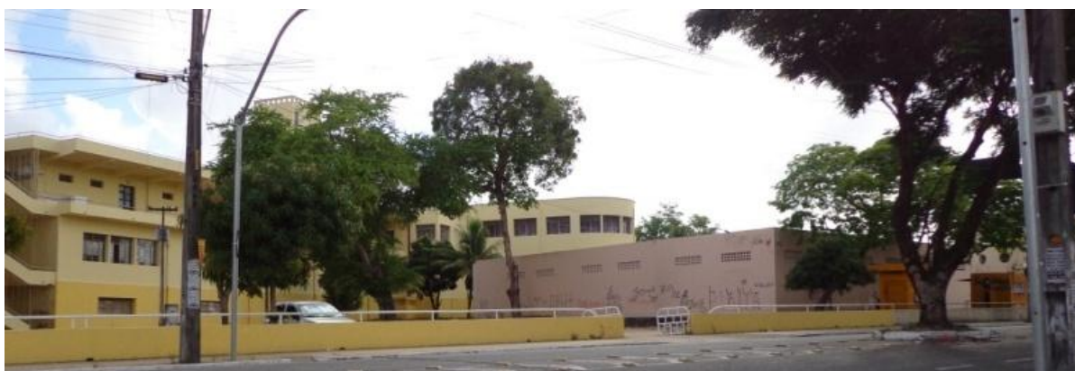
Figura 146: Anexo da Escola Argentina Pereira Gomes, antigo Jardim da Infância. Percebe-se a arquitetura sem expressão do anexo, que ainda interfere na visão do antigo conjunto como um todo, escondendo parte do Edifício Central e Jardim da Infância. Fonte: Acervo da autora, 2013.
