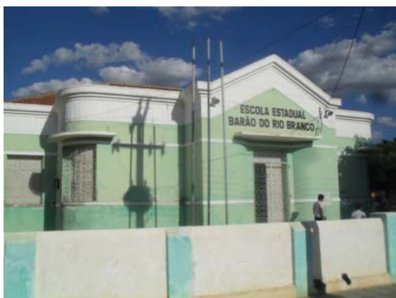
Imagem 54: fachada da Escola. Fonte: acervo pessoal.
