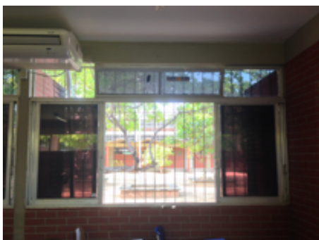
Figura 20 - Esquadria sala de aula dos blocos A, B e D.
