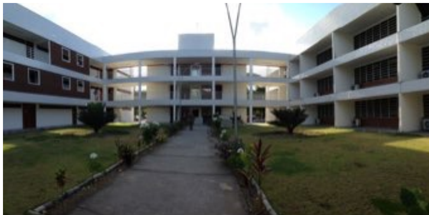
Figura 27 - Edificação na porção oeste do bloco A e B
