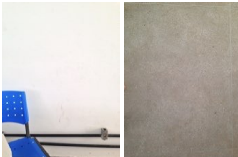
Figura 32 - À esquerda parede emassada e pintada na cor branca. À direita piso em granilite.
