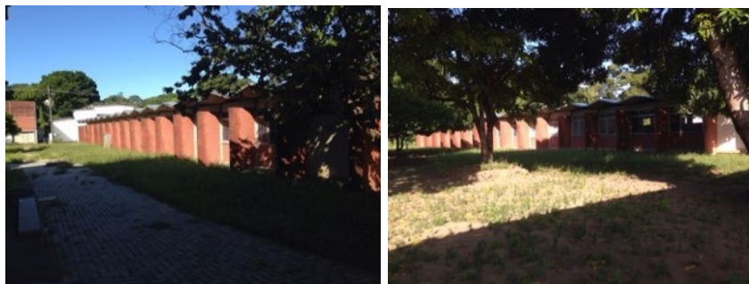
Figura 22 - Foto fachada noroeste bloco D e E.
