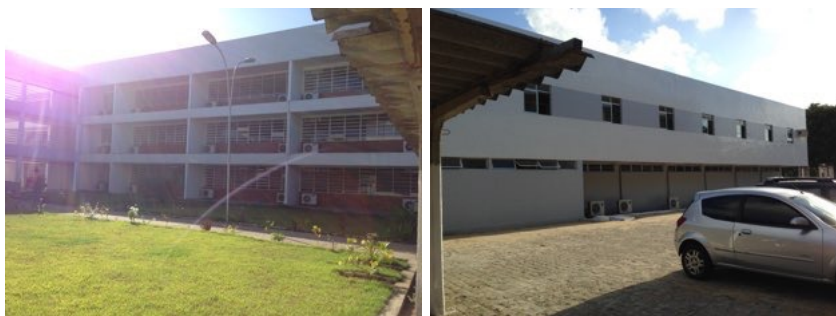
Figura 35 - Edificação a sul do bloco J e a sul do bloco M.
