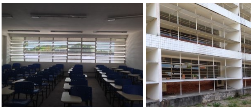
Figura 31 - Esquadria sala de aula bloco J e vista dos brises horizontais.
