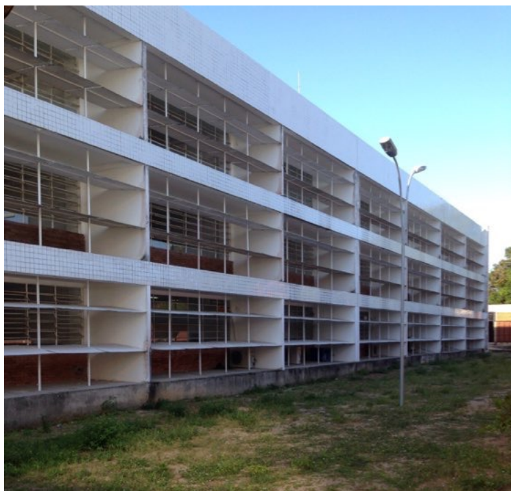
Figura 30 - Vista fachada sul blocos em análise.
