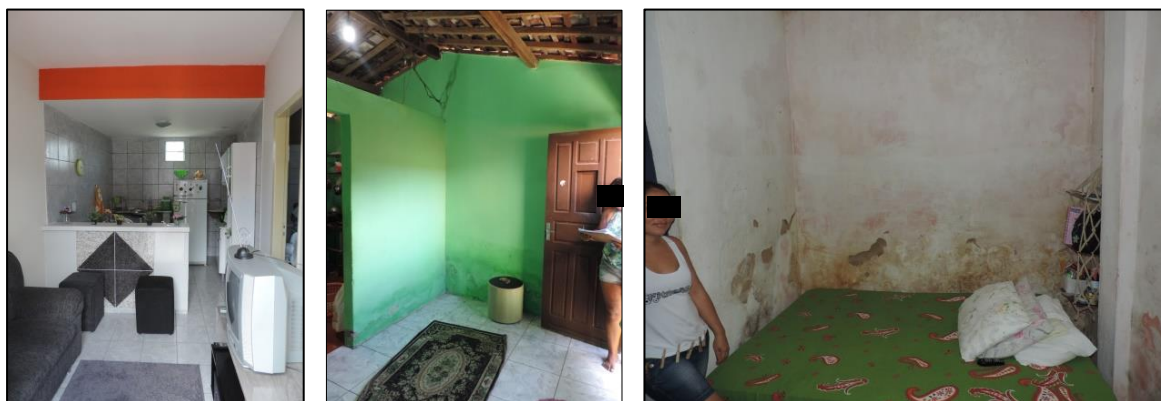
Figuras 65, 66 e 67: Exemplos do estado de conservação da estrutura interna das UHs: HCPA 26 – bom estado, HCPA 38 – estado regular e HCPA 24 – estado deteriorado, respectivamente.
