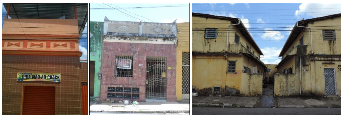
Figuras 62, 63 e 64: Exemplares do estado de conservação das fachadas: HCPA 26 – bom estado, HCPA 13 – estado regular e HCPA 17 – estado deteriorado, respectivamente.
