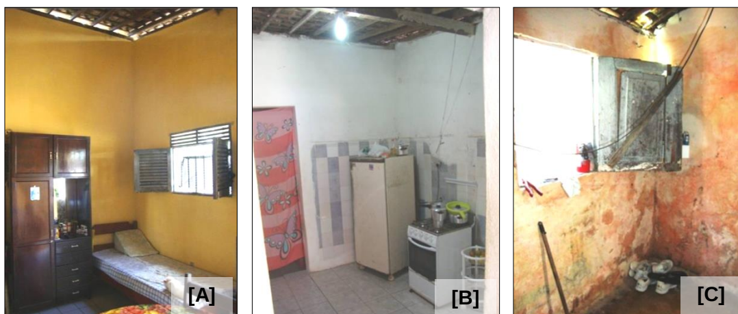
Figuras 44, 45 e 46: Imóveis representando os níveis de conservação da estrutura interna: bom [A], regular [B] e deteriorado [C].
