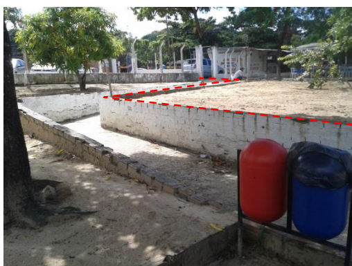
Figura 18: Fotografia da rampa de acesso ao nível do ambulatório
