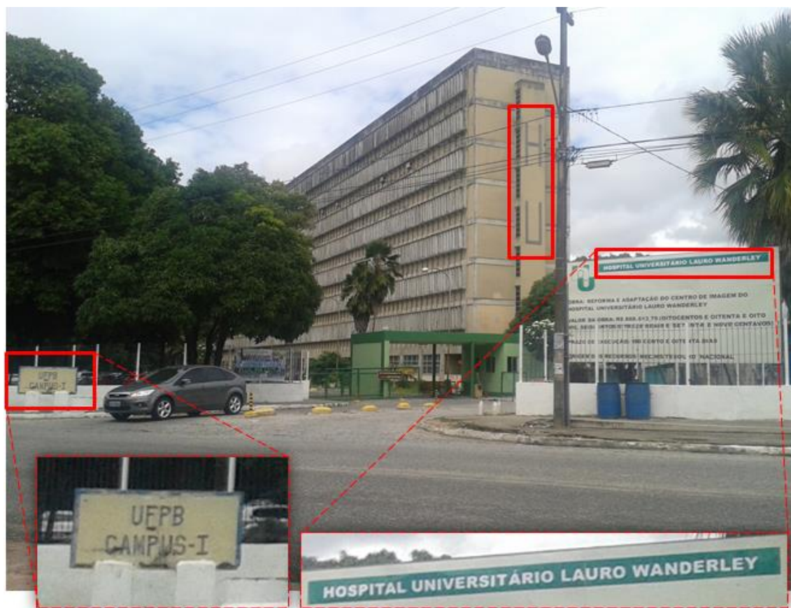
Figura 21: Imagens da sinalização bastante precária existente no entorno do Hospital Universitário
