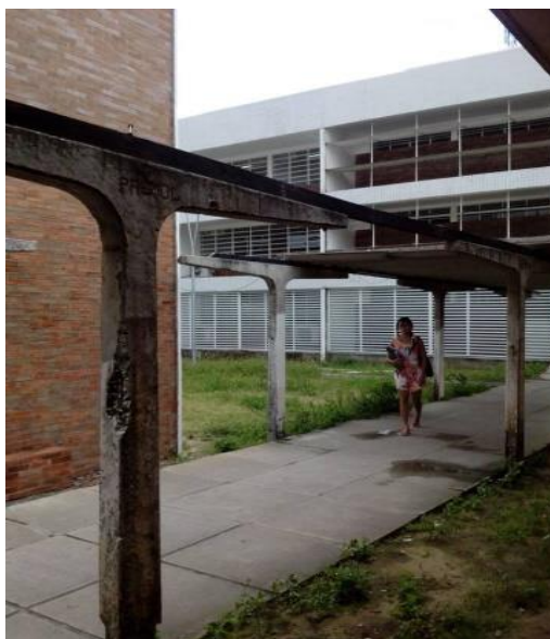
Figura 38 – Passarela do CCT/UFPB.
