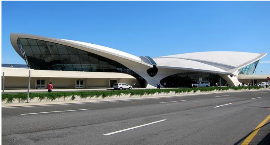
Figura 2 - Terminal TWA, no Aeroporto JFK, em Nova York.
