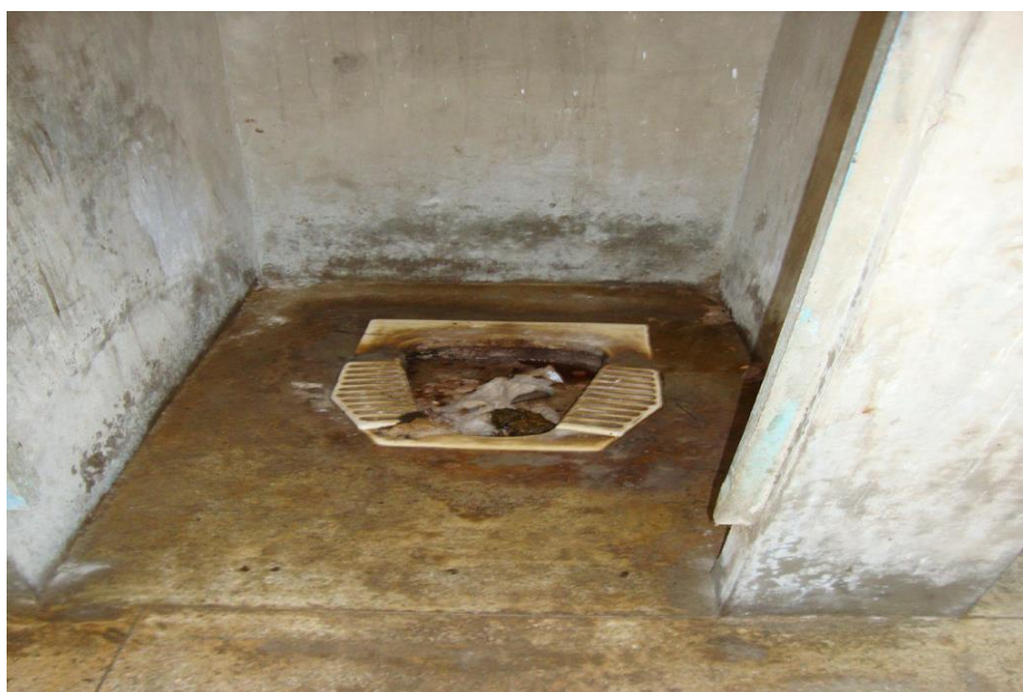
Figura 01: Banheiro Coletivo no CEA, 2011
