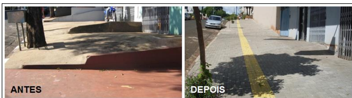
Figura 5. Retirada de degraus entre testadas.
