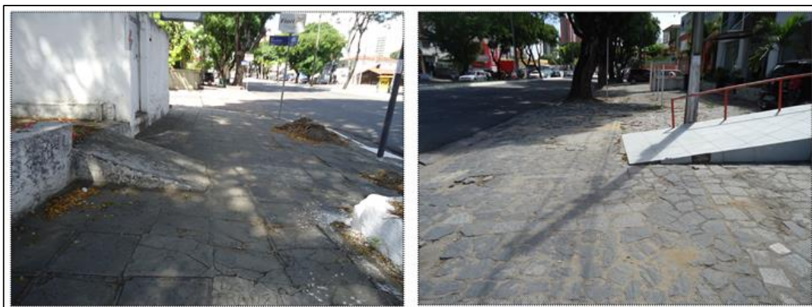
Figura 26. Exemplos de apropriações privadas através de rampas.
