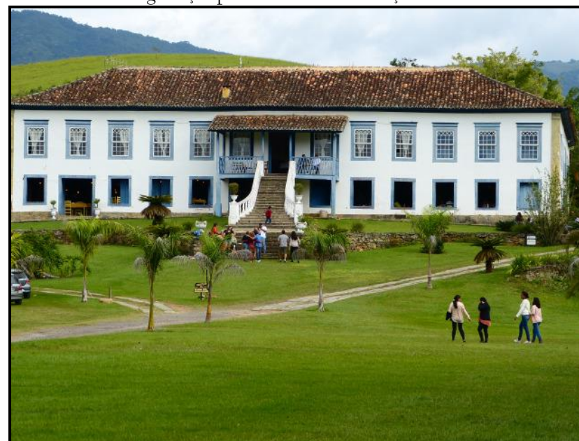
Figura 13: Casarão construído em 1780, hoje pertencente ao Hotel Fazenda de Boa Vista, na cidade de Bananal – SP, que serviu de gravação para a novela Sinhá Moça .
