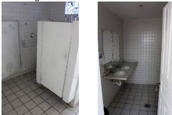
Figura 58. Vistas do banheiro feminino
