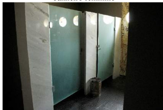
Figura 81. Vista dos boxes com sanitários do banheiro feminino
