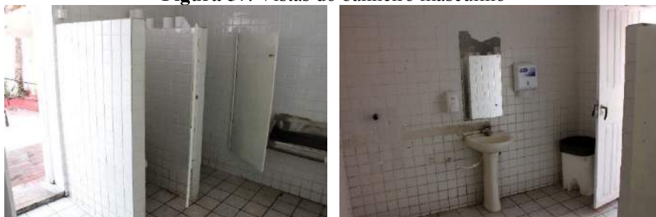
Figura 57. Vistas do banheiro masculino
