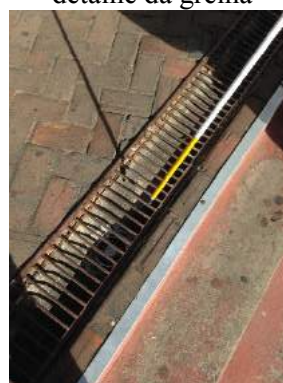
Figura 50. Grelha instalada próxima ao degrau e detalhe da grelha
