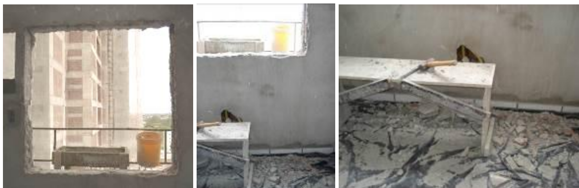
Figura 50: Quebra na alvenaria para substituição de contramarcos.
