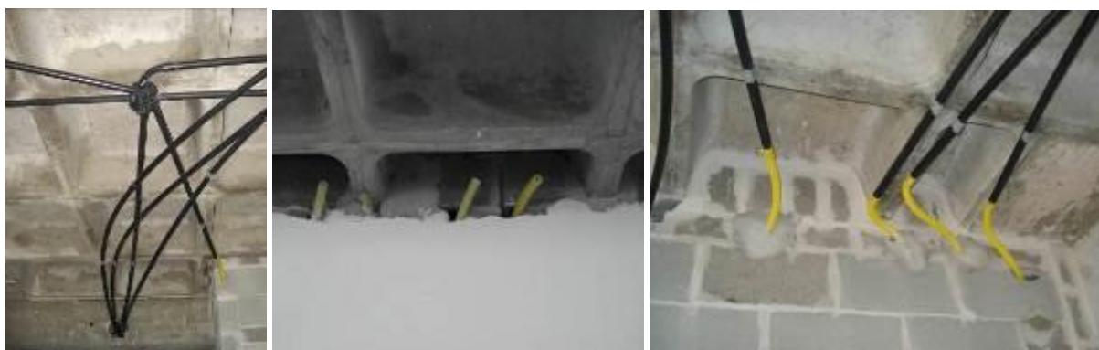
Figura 65: Distribuição horizontal das instalações, abaixo da laje.
