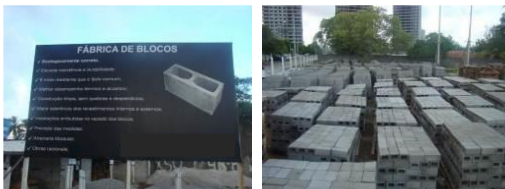
Figura 60: Fábrica de blocos montada pela construtora responsável pelo projeto nº 212 (01/2008).
