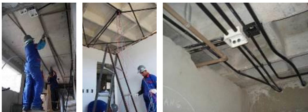
Figura 46: Distribuição horizontal das instalações na obra do Projeto nº 207 (09/2007).
