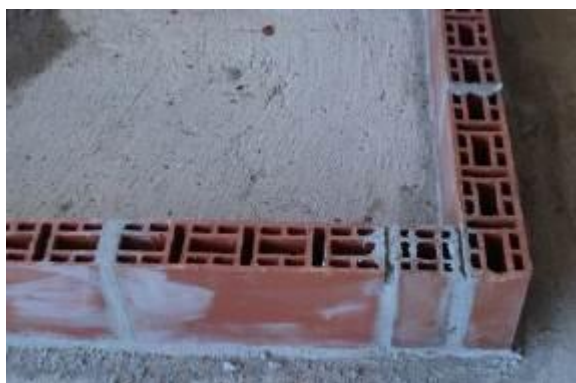
Figura 41: Primeira fiada de alvenaria com blocos cerâmicos racionalizados.
