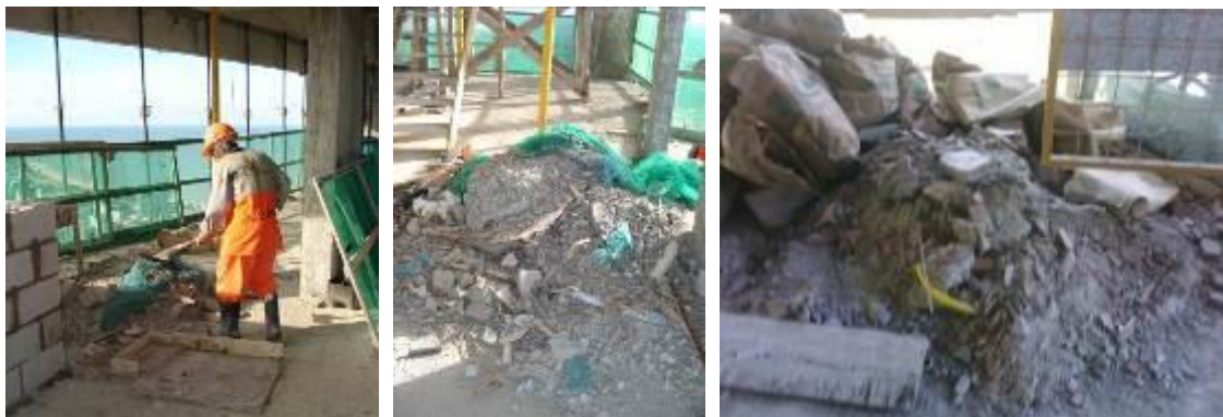
Figura 70: Acondicionamento inicial do RCC em pilhas por pavimento.
