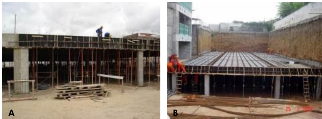
Figura 77: Escoramento da laje nervurada nas obras visitadas.
