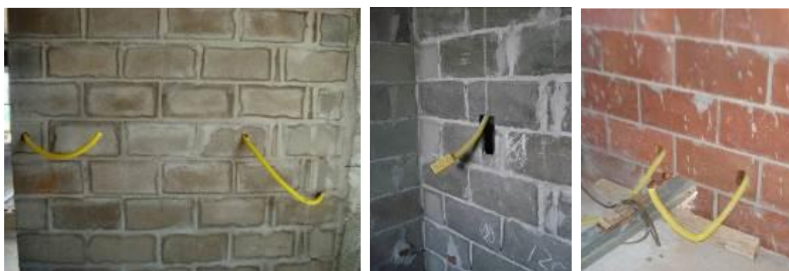
Figura 66: alimentação dos pontos elétricos através dos blocos racionalizados.
