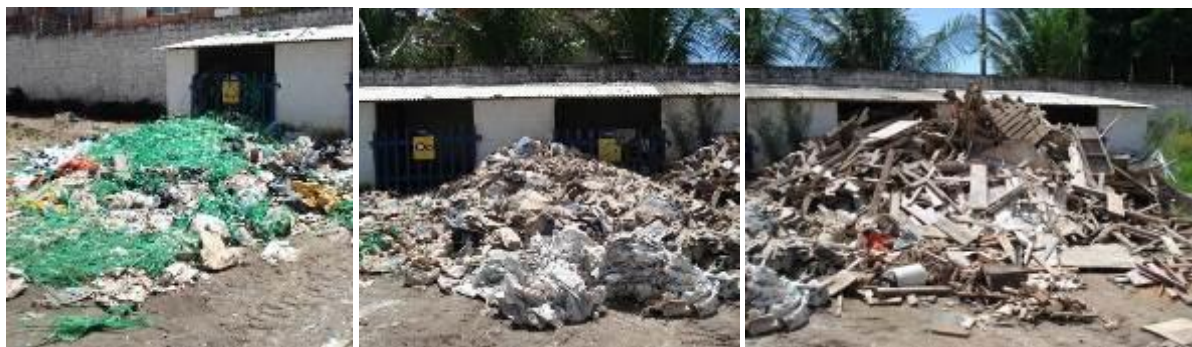
Figura 55: Baias de resíduo Classe B com sua capacidade esgotada.
