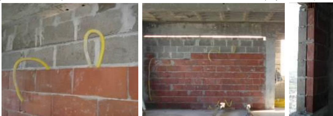
Figura 62: Parede dupla com bloco de concreto e bloco cerâmico na face oeste do projeto nº212 (01/2008)
