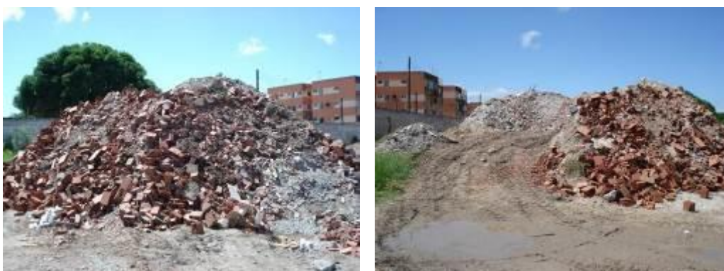
Figura 53: Pilha de resíduo Classe A na obra do Projeto nº 207 (09/2012).
