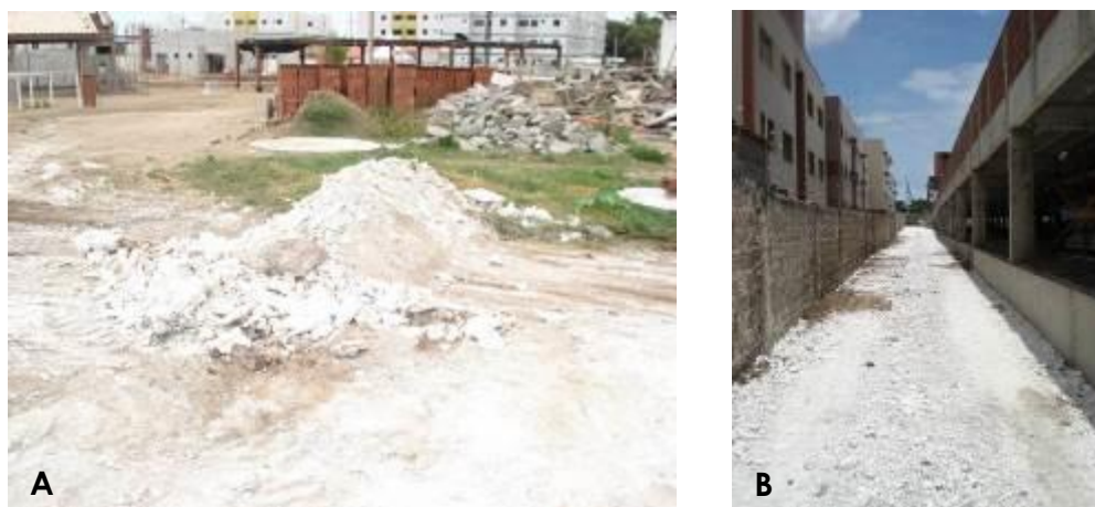
Figura 52: Tratamento do resíduo de gesso na obra do Projeto nº 207 (09/2012).
