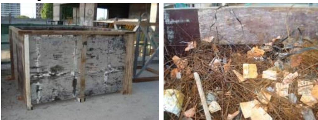
Figura 73: Acondicionamento final do resíduo de metal em caixotes de madeira.
