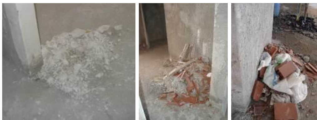
Figura 54: Acondicionamento inicial do RCC por pavimento na obra do projeto nº 207 (09/2007).
