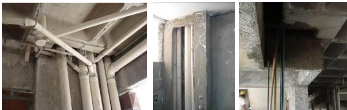
Figura 44: Shafts na obra do Projeto nº 207 (09/2007).
