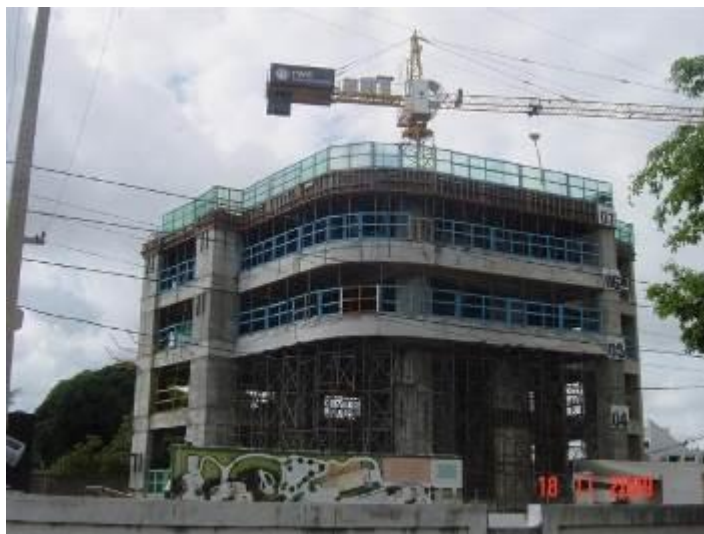
Figura 59: Andamento da obra do projeto nº212 (01/2008) em novembro de 2009.
