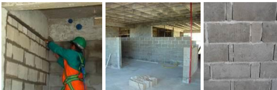
Figura 61: Alvenaria racionalizada na obra do projeto nº 212 (01/2008).
