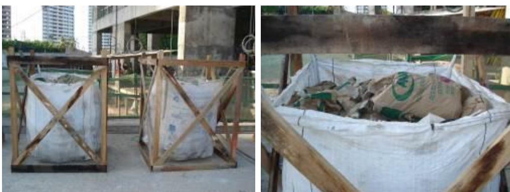
Figura 74: Acondicionamento do resíduo de papel em bombonas com saco de ráfia.
