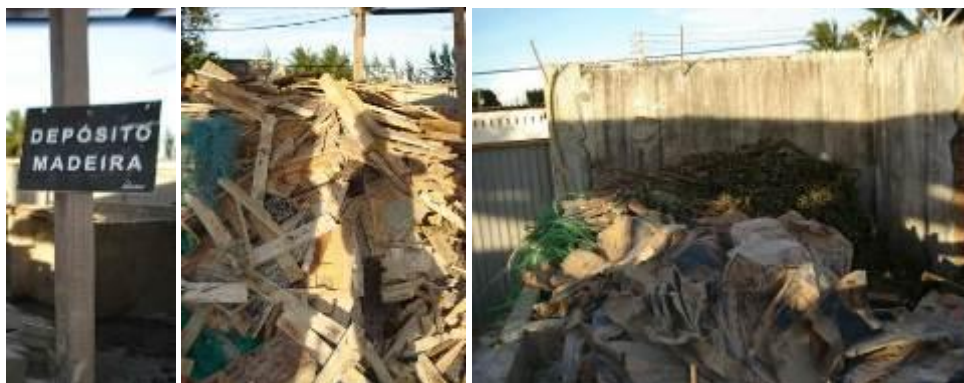
Figura 75: Acondicionamento do resíduo de madeira e papel em baias com a capacidade esgotada.
