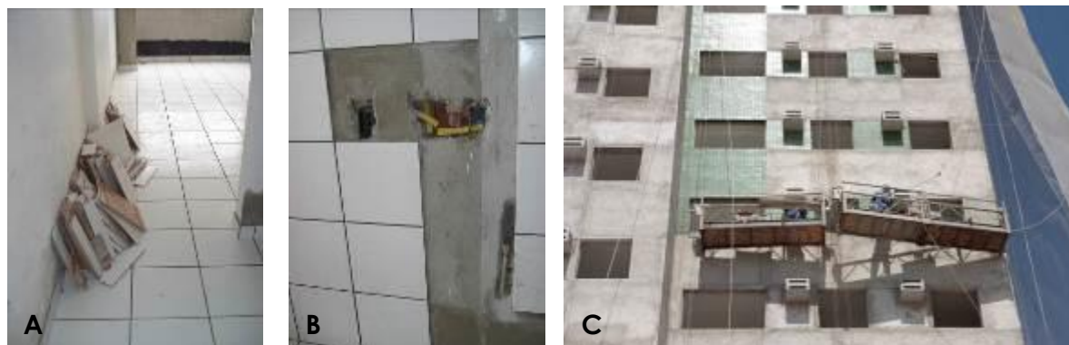
Figura 49: Revestimento interno/revestimento externo na obra do Projeto nº 207 (09/2007).
