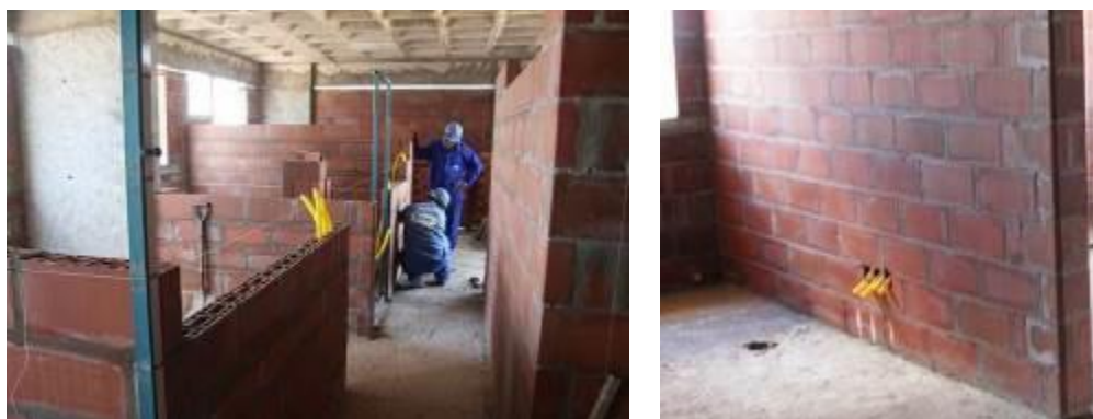
Figura 47: Instalação dos dutos de eletricidade sem corte na alvenaria.
