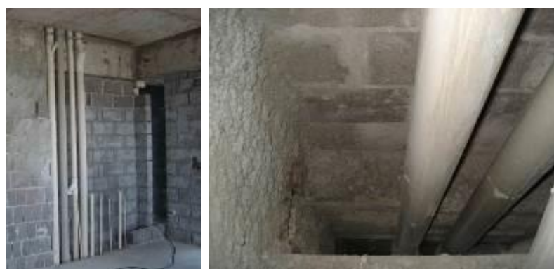
Figura 63: Shafts na obra do projeto nº 212 (01/2008).
