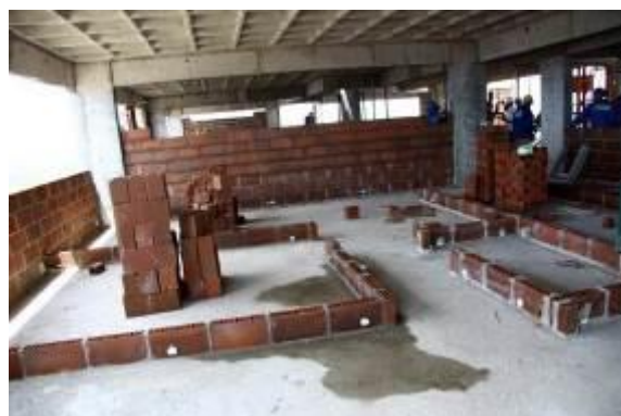
Figura 41: Primeira fiada de alvenaria com blocos cerâmicos racionalizados.
