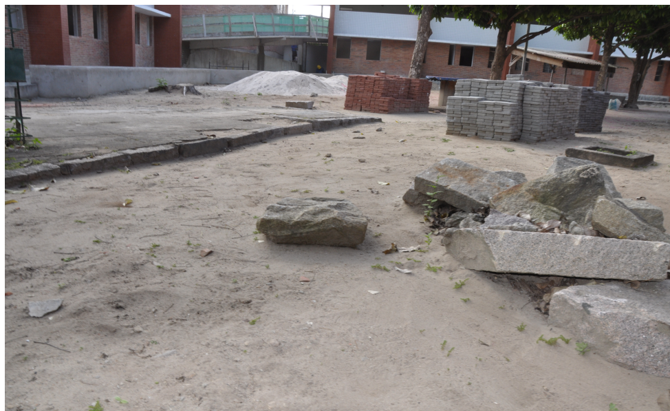
IMAGEM 15: Visão lateral esquerda do futuro prédio.
