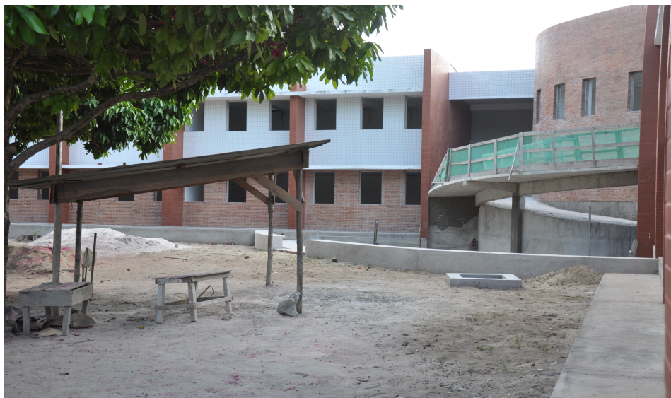
IMAGEM 14: Visão lateral direita do futuro prédio.
