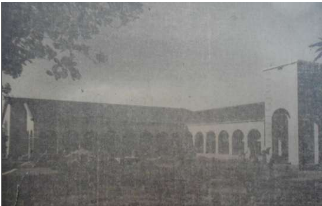
Figura 41 – Outro ângulo da parte externa do Grupo Escolar de Alagoa Nova 86 .
