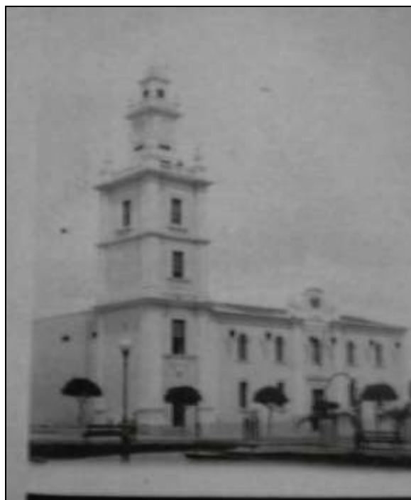
Figura 7 – Prédio onde funcionou o Lyceu Paraybano de 1839 a 1939, quando foi transferido para as modernas instalações do Instituto de Educação, na Avenida Getúlio Vargas.
