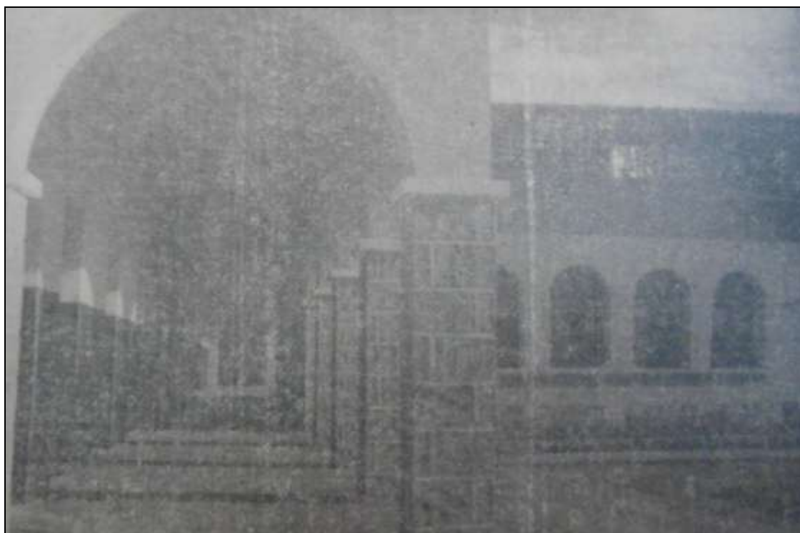
Figura 42 – Vista parcial interna (corredor) do Grupo Escolar de Alagoa Nova – 1945.
