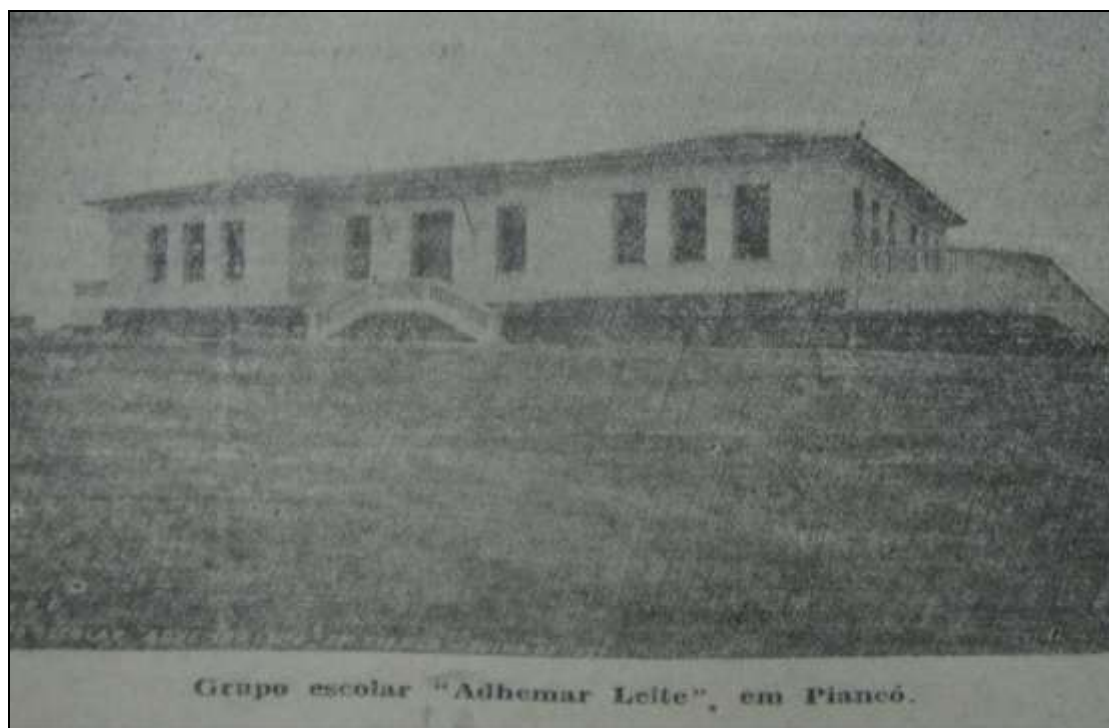
Figura 34 – Grupo Escolar Adhemar Leite, em Piancó, obra já bastante adiantada – 1938.
