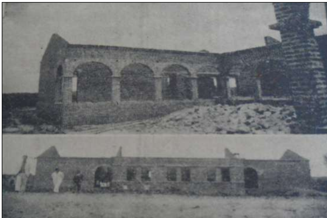
Figura 43 – Dois ângulos do Grupo Escolar de Ibiapinópolis (atual Soledade), ainda em construção – 1945.
