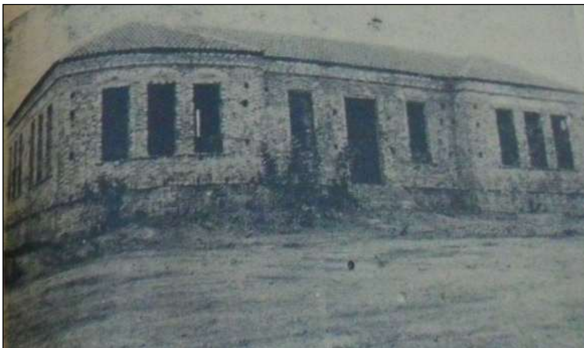
Figura 29 – Grupo Escolar de São José de Piranhas – em construção – 1934.
