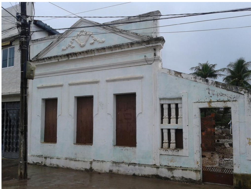
Figura 10- Fachada do prédio onde funcionou o Instituto Nossa Senhora do Carmo
