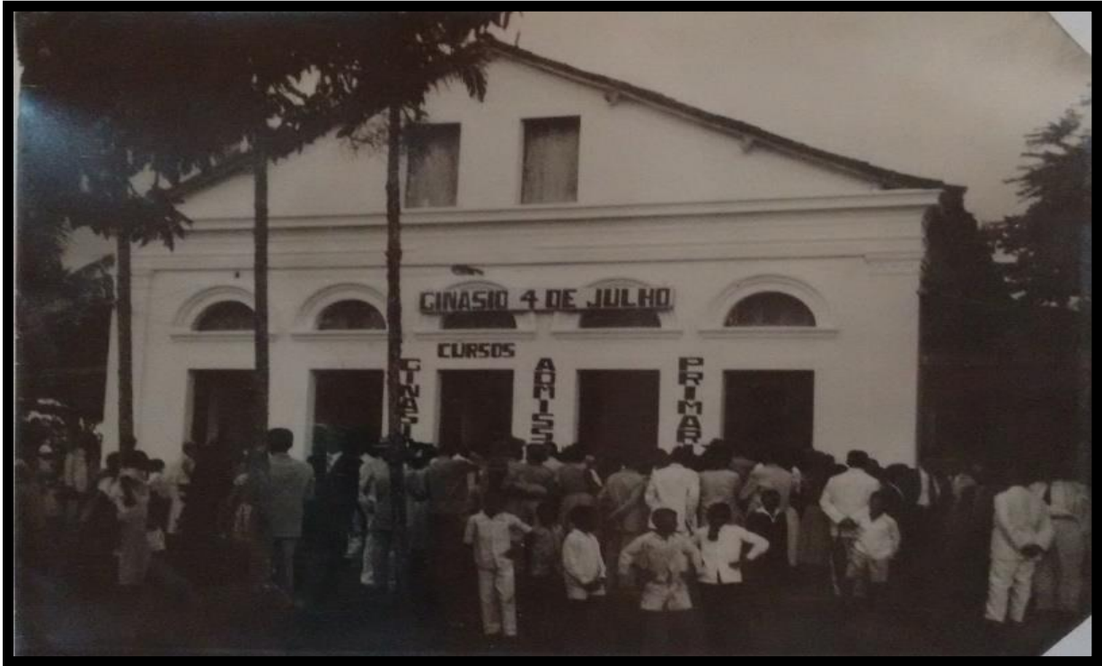
FIGURA 19 - Ginásio 4 de Julho (s/d)
