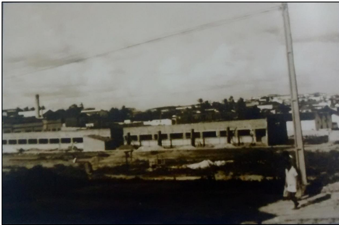
Figura 20: Construção do Mercado da Prata em 1960
