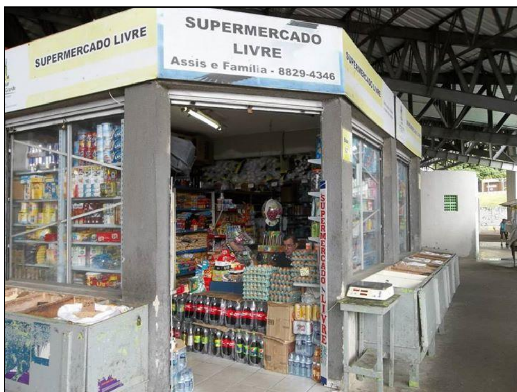
Figura 39: Ilha da Feira da Prata com alterações na estrutura
