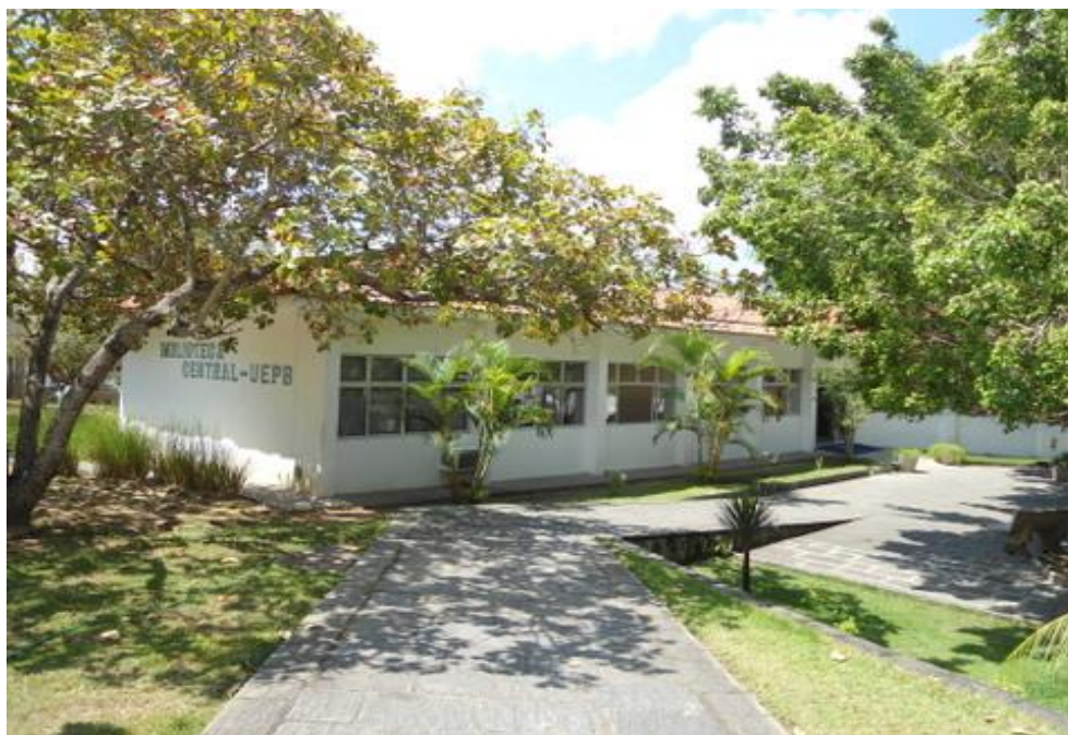
Figura 9 – Fachada da Biblioteca Central (Campus I)
