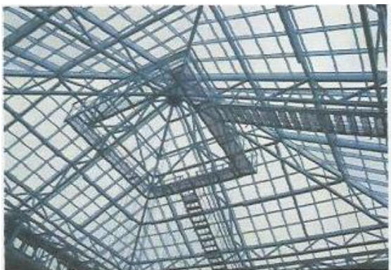
Figura 48 - Texto imagético: vista de uma estrutura de cobertura.
