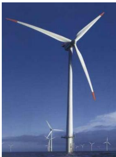
FIGURA 2.3: AEROGERADOR EÓLICO DE ELETRICIDADE 3 .
